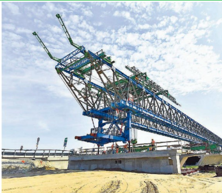
Nella foto la costruzione del ponte sul Tagliamento nell'ambito dei lavori per la terza corsia della A4
