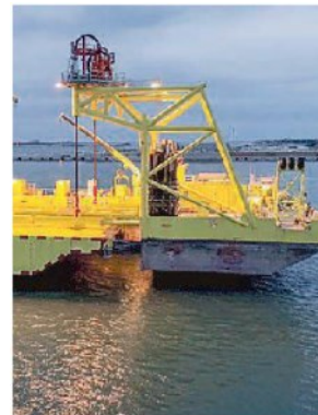
Posa dell'ultima paratoia
