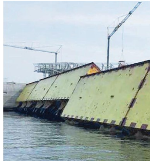
Prova e collaudo per le paratoie di Chioggia
