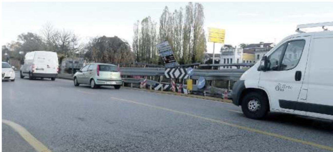
VIABILITÀ Cantiere nuovamente aperto al ponte sul canale Taglio, in centro, a Mira.
