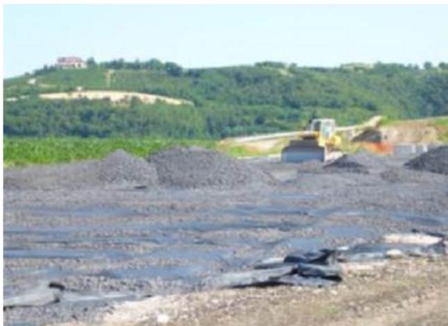
Il sottofondo del sedime autostradale nella zona di Montegaldella
