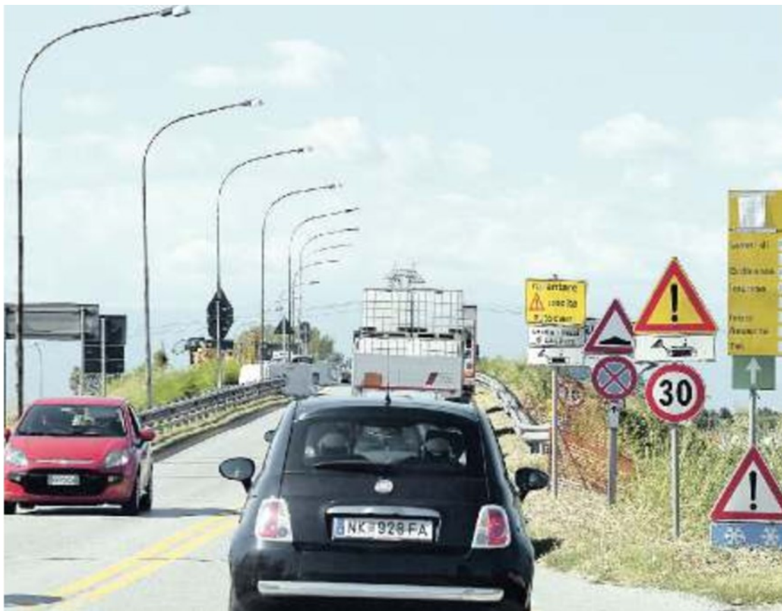
TANGENZIALE I lavori in corso sul cavalcavia a Portogruaro in viale Pordenone, la sp 251
