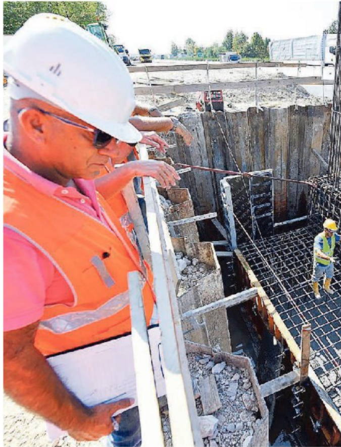
Cantiere della terza corsia autostradale lungo la Venezia-Trieste
