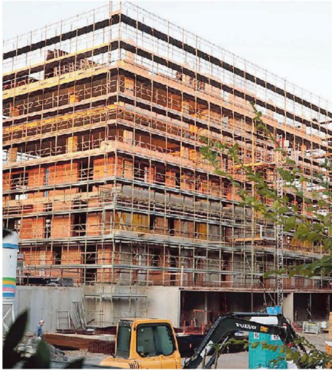
Il cantiere del Bosco verticale, sotto la pagina de la tribuna di lunedì
