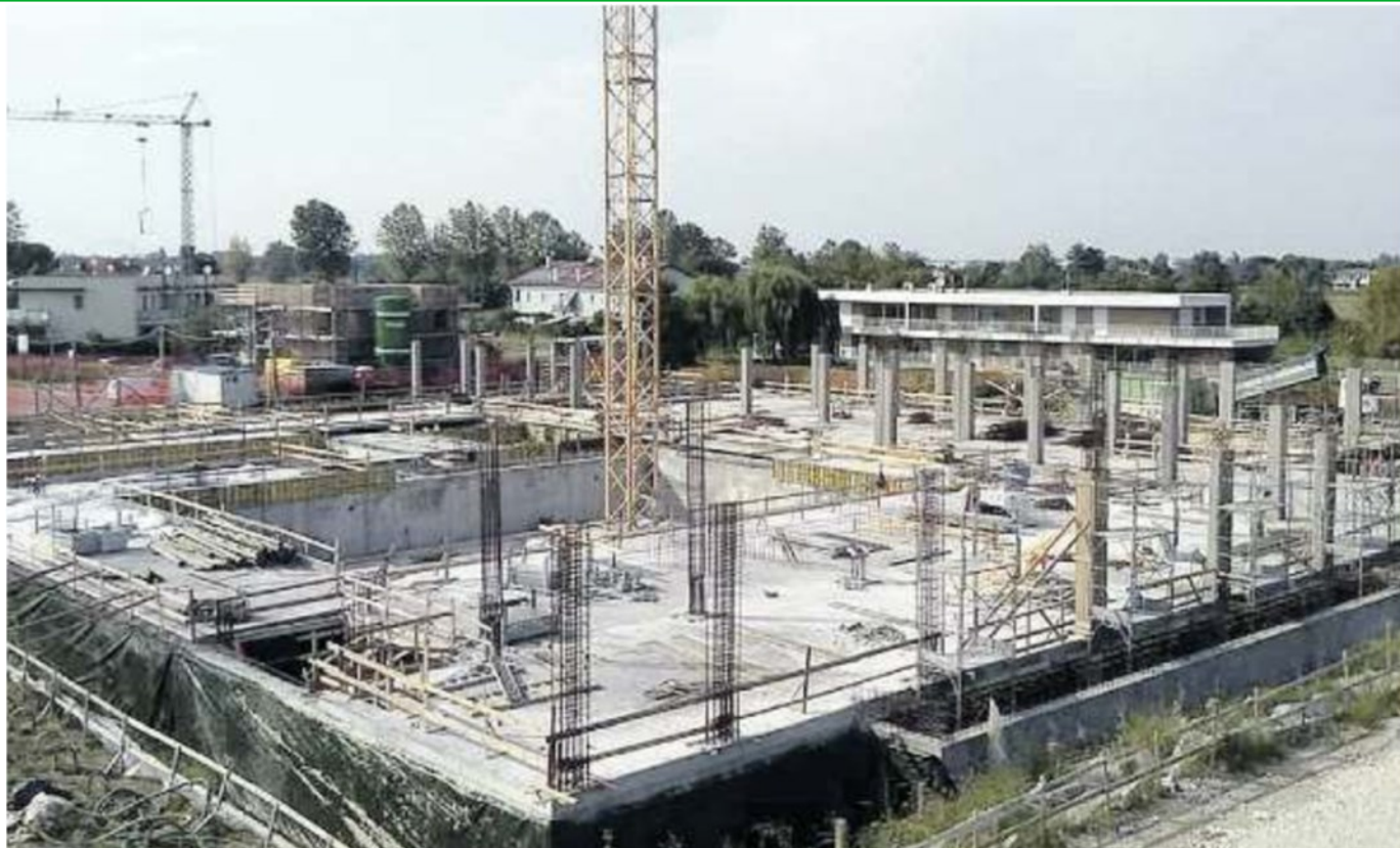
NUBI SCURE Si addensano sul faraonico cantiere dell'impianto natatorio di Tencarola: lavori in ritardo e ditte subappaltatrici non pagate
