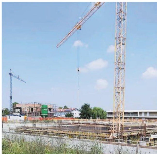
Il cantiere della nuova piscina a Tencarola di Selvazzano
