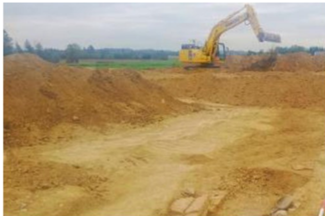
I lavori per la bonifica dei terreni sono già iniziati a Desenzano
