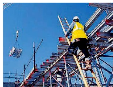
Un cantiere edile
