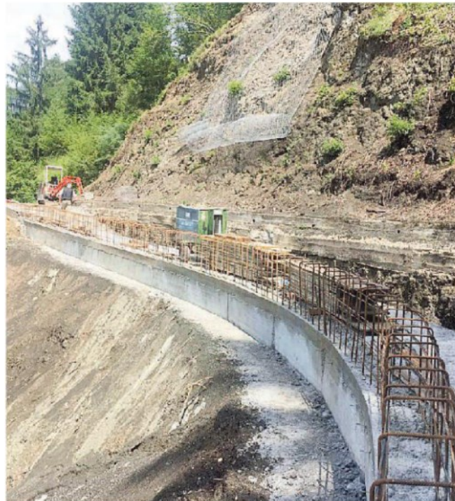
Un cantiere aperto a Valle di Cadore dopo Vaia
