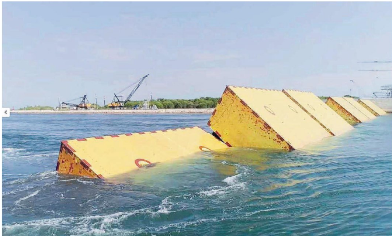
Le paratoie del sistema Mose durante una prova di sollevamento, nei mesi scorsi, alla bocca di porto di San Nicolò al Lido
