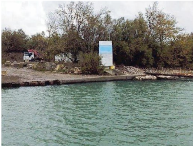
L'isola delle Tresse dove vengono conferiti i fanghi
