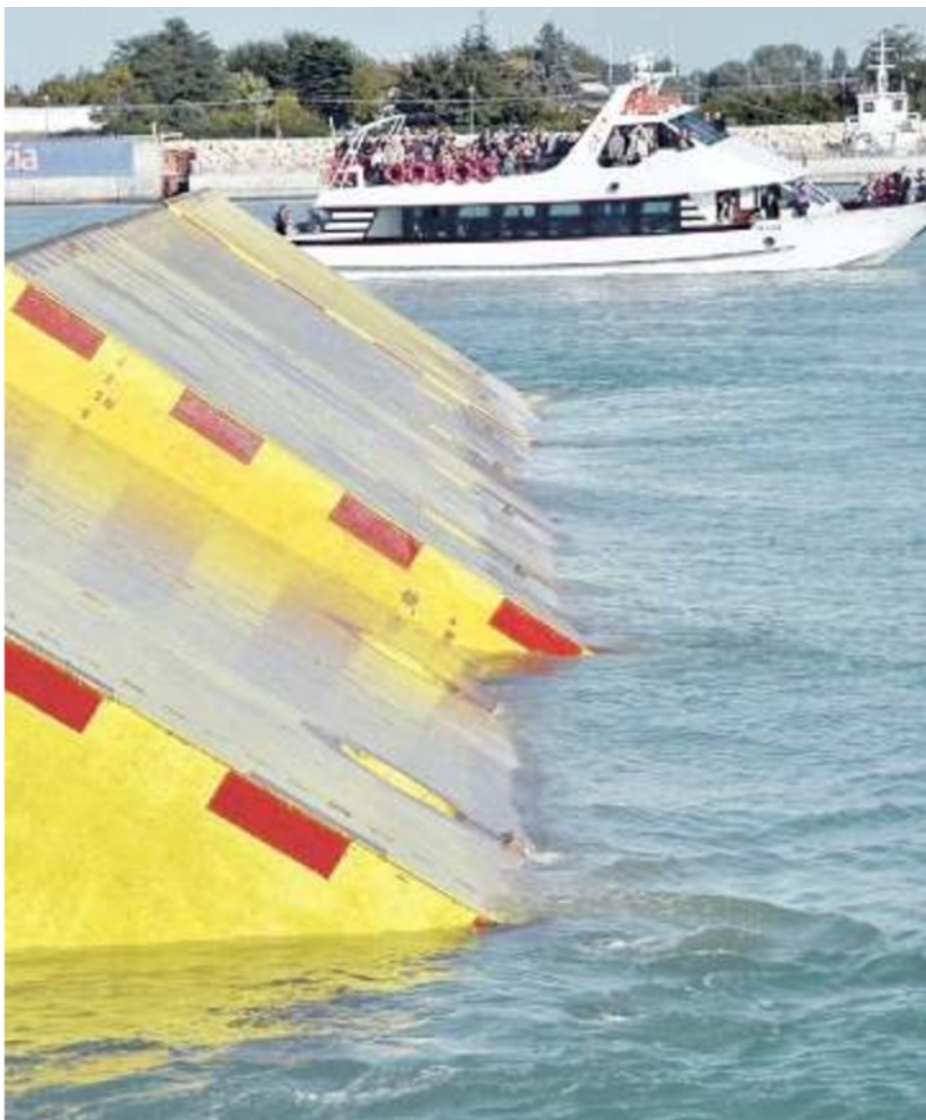
IL SISTEMA Le dighe mobili gialle durante una prova di funzionamento nella laguna di Venezia
