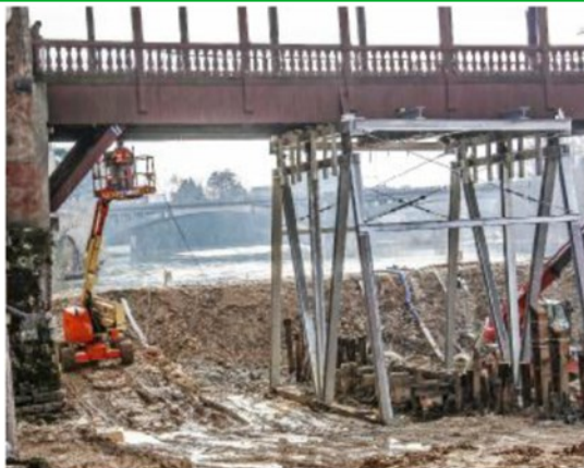
Ultimi ritocchi prima di procedere al sollevamento del monumento
