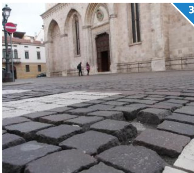
Gli interventi sono concentrati nella zona di piazza Duomo e vie limitrofe
