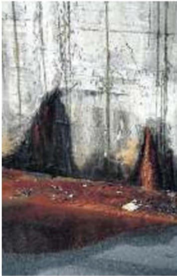
PERICOLOSA L'infiltrazione d'acqua in via Forlanini
