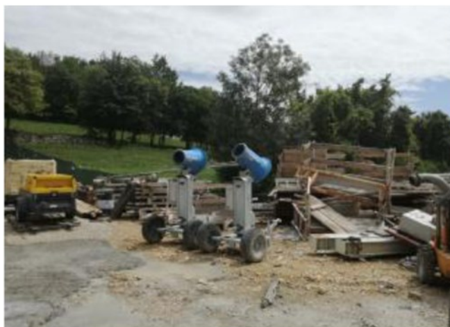
I cannoni per l'abbattimento delle polveri in cantiere
