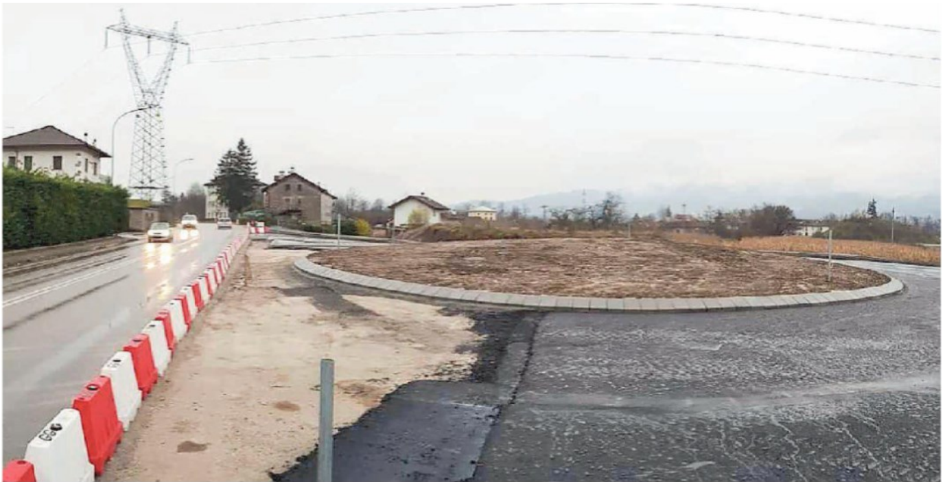
La rotonda a servizio dell'area artigianale di Levego, realizzata dal Consorzio Quadrante e quasi ultimata
