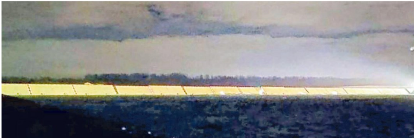
La barriera del Mose con tutte le paratoie alzate alla bocca di porto di Malamocco
