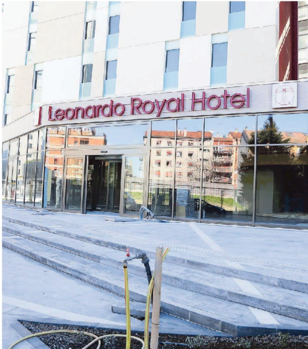
Il District Hotel di via Ca' Marcello
