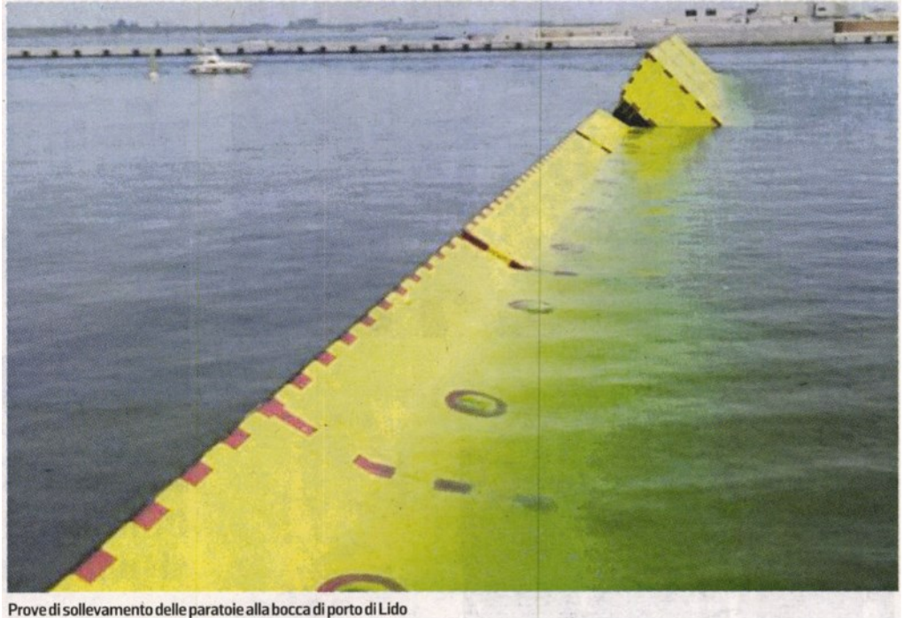
Prove di sollevamento delle paratoie alla bocca di porto di Lido
