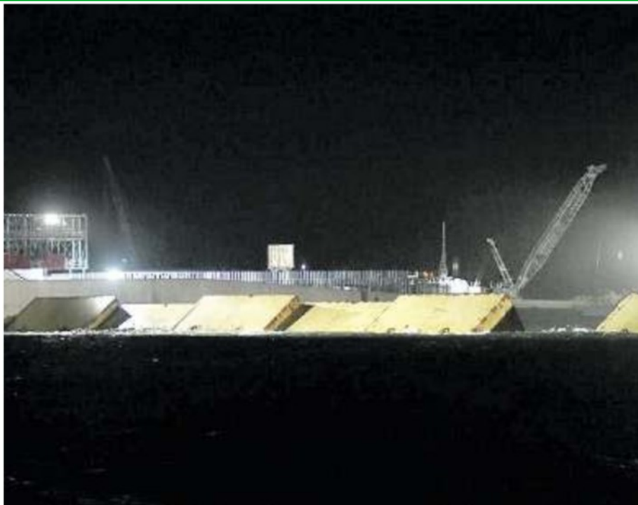
MALAMOCCO Sopra, il test del Mose di lunedì scorso e nella tabella a destra il confronto con i dati meteo marini delle ultime due acque alte eccezionali
