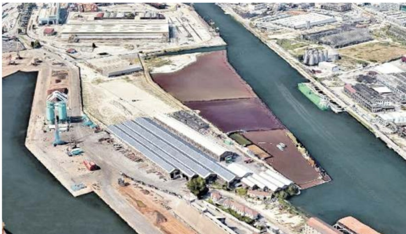
DALL'ALTO L'area del Molo Sali (al centro in marrone) che verrà riempita da 500mila metri cubi di fanghi scavati dal canale dei Petroli
