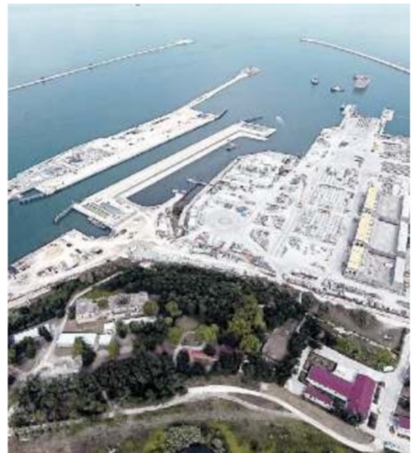
PELESTRINA La conca di navigazione alla bocca di porto di Malamocco
