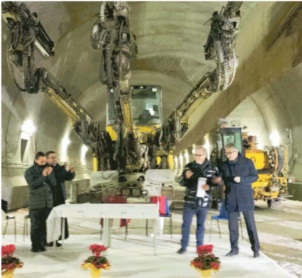
Ilavori nel traforo di Santa Augusta
