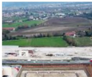
Scorcio del cantiere. FOTO CECCON
