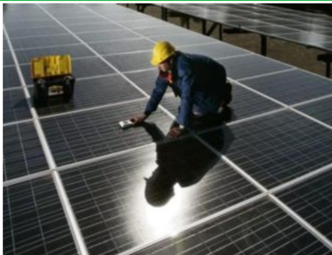
L'installazione di pannelli solari
