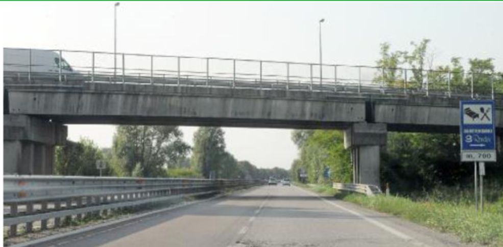
Cavalcavia sulla Transpolesana all'altezza di Legnago: siglato accordo con l'Anas per la manutenzione
