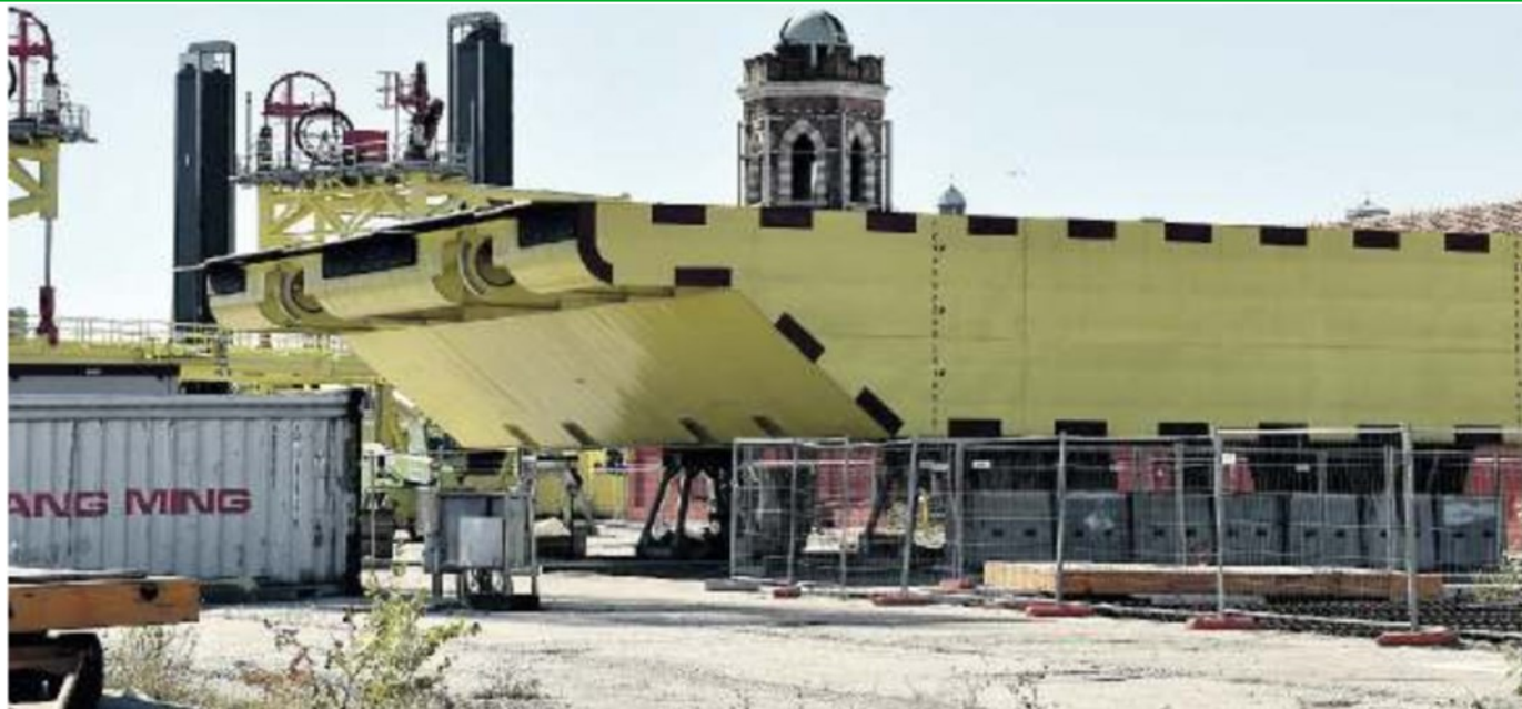
MANUTENZIONI Una paratoia del Mose all'Arsenale, uno dei due luoghi che potrebbero essere scelti per le manutenzioni
