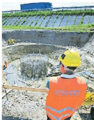
Un cantiere della terza corsia
