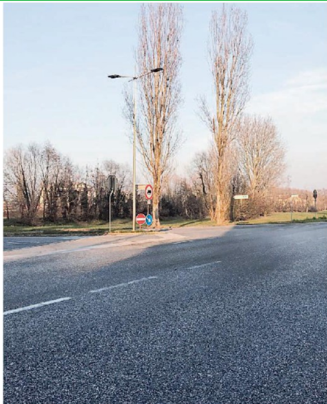
Via Pasteur a Dolo dove sarà realizzata la rotatoria
