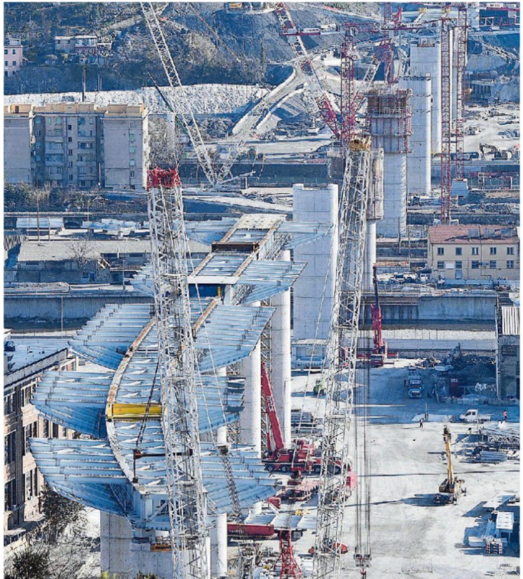
Il nuovo ponte di Genova che andrà a sostituire il Morandi, crollato il 14 agosto 2018
