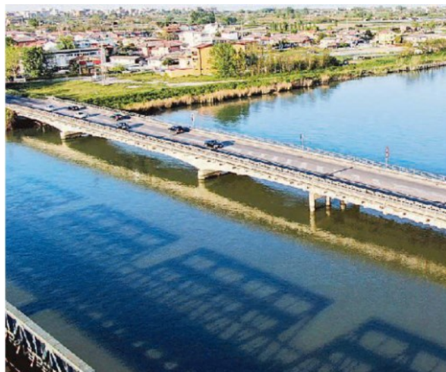
Il ponte sul Brenta: da martedì via ai lavori
