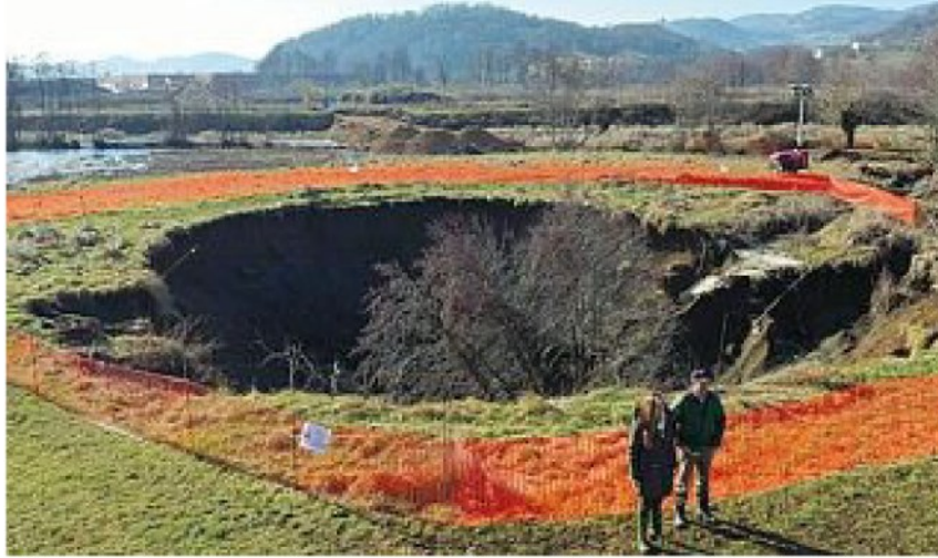
A duecento metri dalle case La voragine che si è aperta durante i lavori di scavo di una galleria
