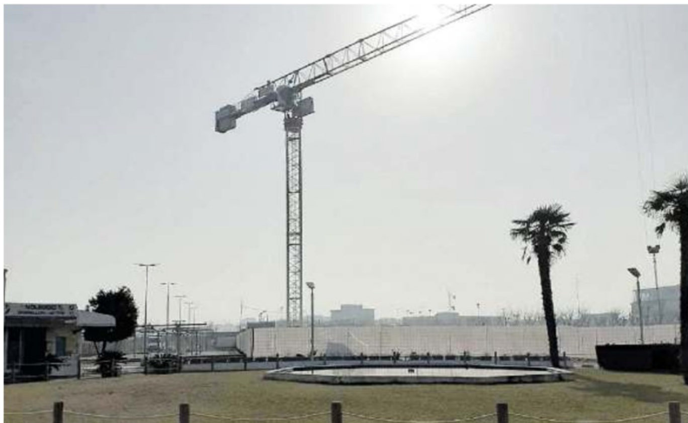
IL CANTIERE Una gru nel cantiere di Sottomarina, dove dovrebbe sorgere un nuovo grande supermercato
