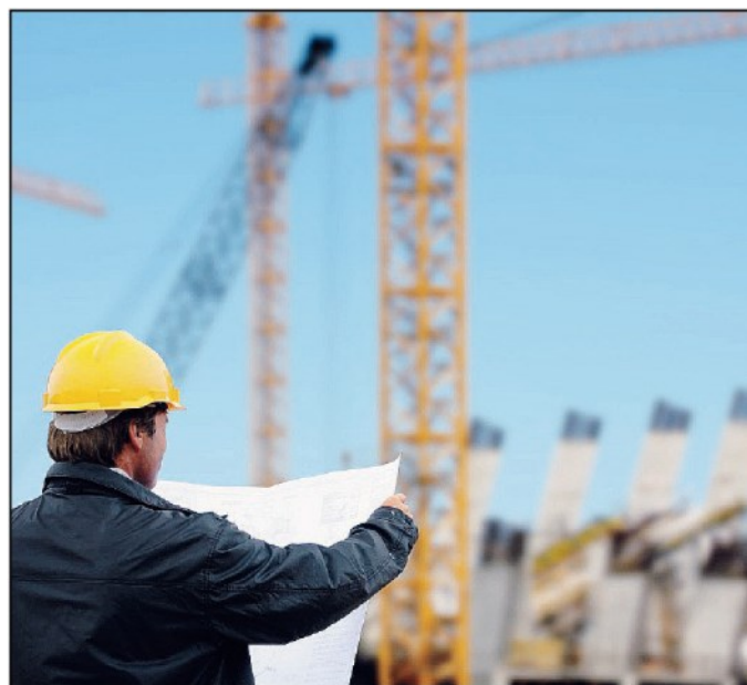
Cantiere in corso
