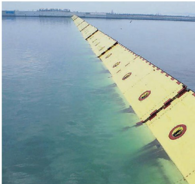
Prove di sollevamento della barriera del Mose a San Nicolò
