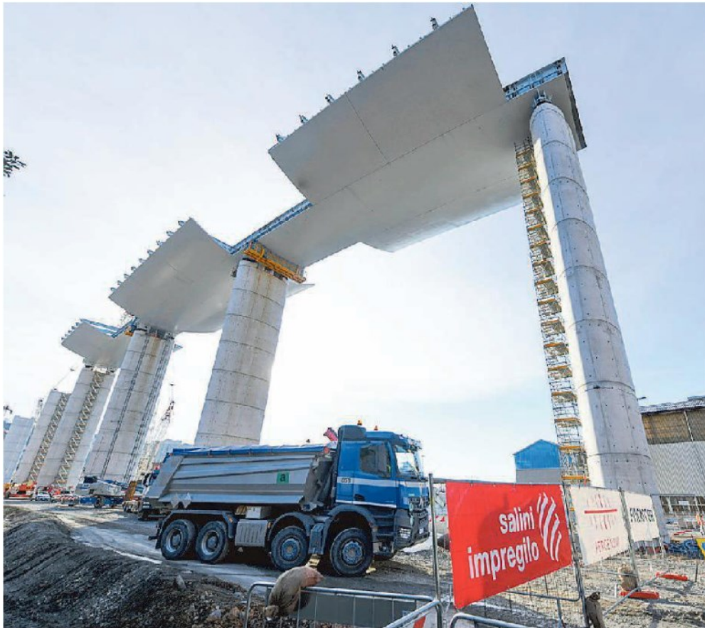
Il cantiere per la ricostruzione del ponte Morandi
