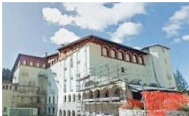
L'albergo ex Cortina Tre Croci in ristrutturazione
