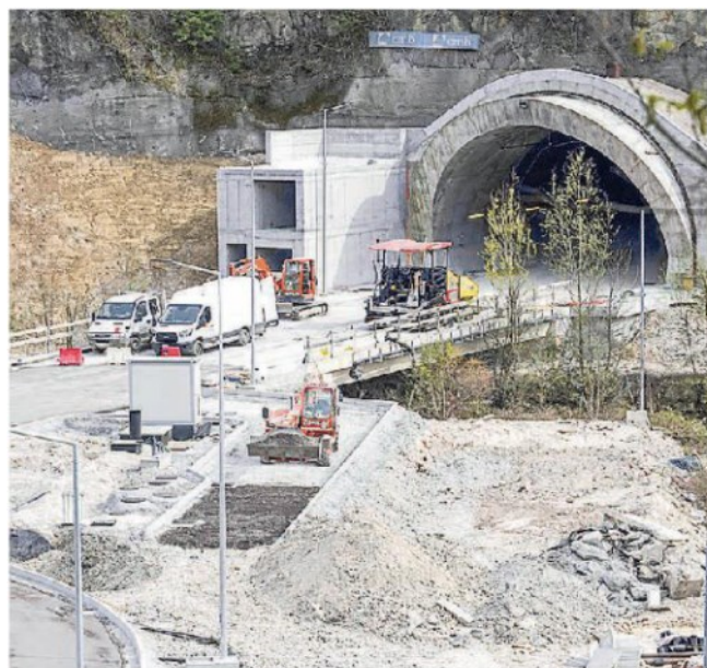
Il cantiere nord del traforo di Santa Augusta la scorsa primavera
