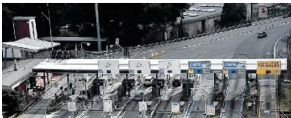
La zona del casello autostradale di Genova Est
