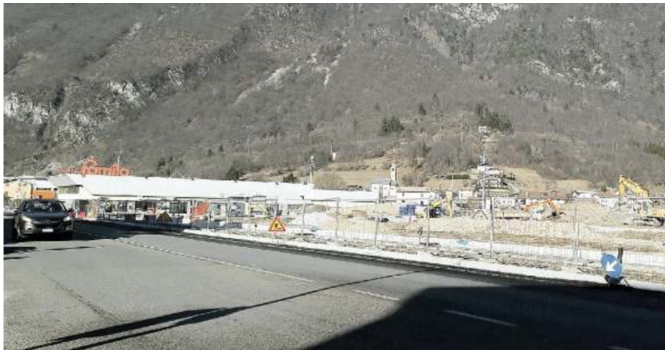
VIALE DOLOMITI La statale 50 sarà interrotta per poter realizzare la rotonda e il traffico passerà all'interno del cantiere stesso
