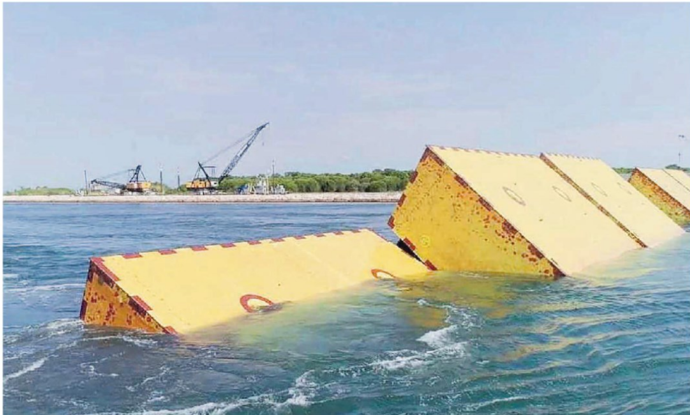
Le paratoie del Mose durante uno degli ultimi sollevamenti di prova: ora si cercano i soldi per concludere i lavori
