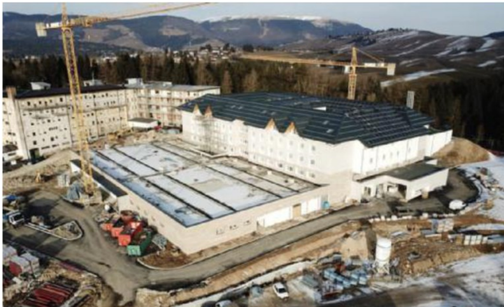
La costruzione del nuovo ospedale di Asiago è ormai ultimata
