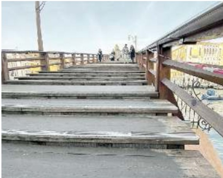
I GRADINI La parte in legno è la più delicata
