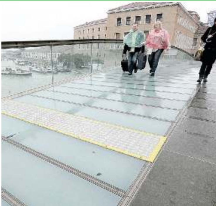
PONTE DI CALATRAVA I gradini in vetro saranno sostituiti
