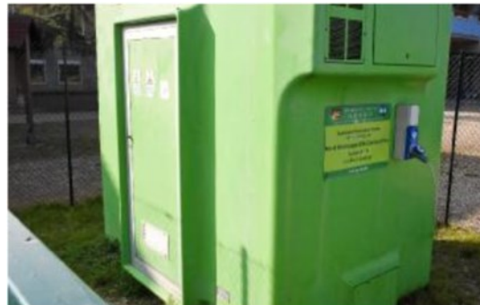
La centralina Arpav installata in via Fiume a San Bonifacio
