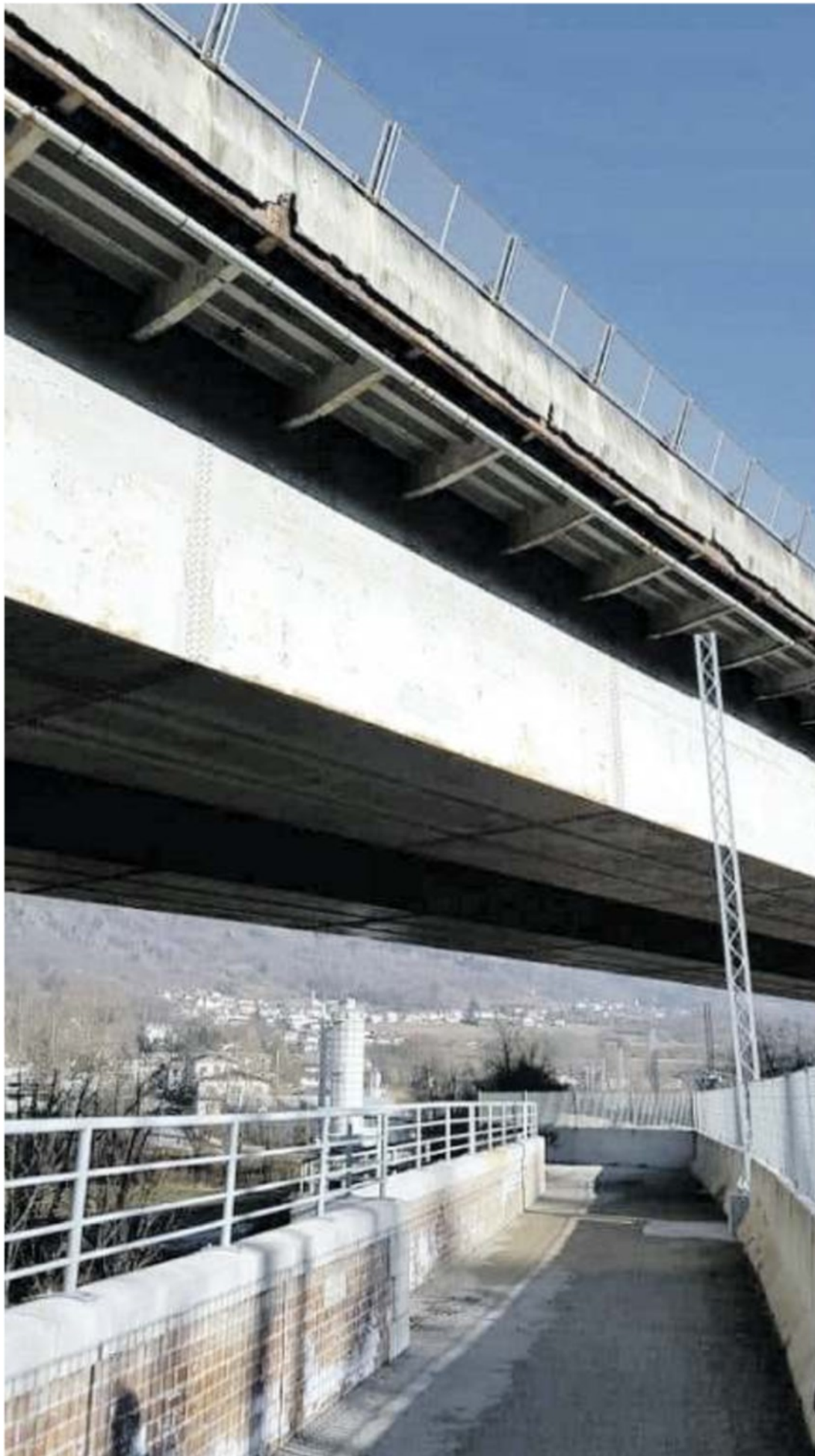
CADOLA Una foto eloquente, postata da un cittadino su Facebook, evidenzia lo stato dell'intonaco
