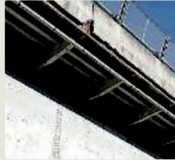
G. Santin a pagina XI EVIDENTE Il deterioramento
