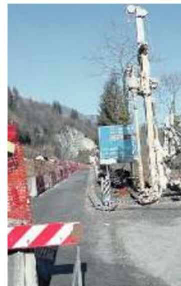
IL NUOVO CANTIERE A Ponte Serra lavori lungo la Regionale 50
