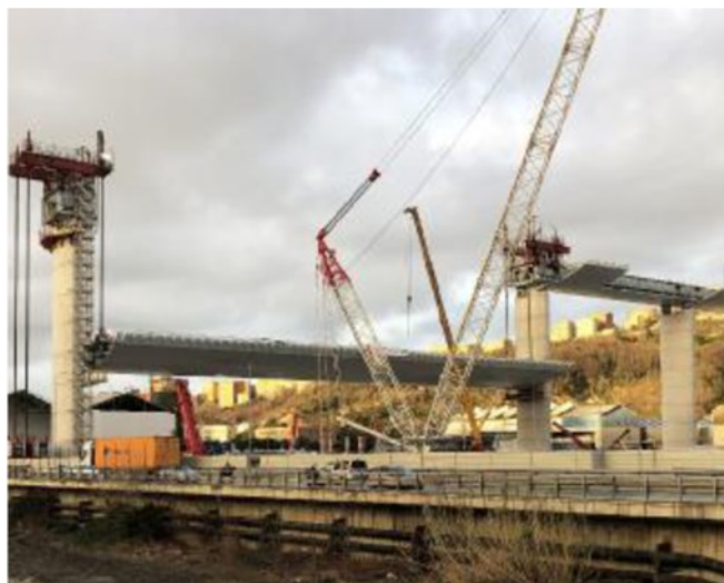
Il maxi impalcato del nuovo ponte Morandi di Genova
