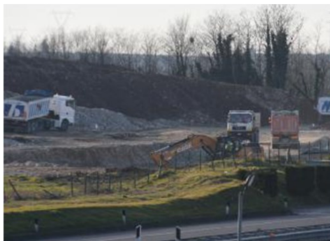
Il cantiere per la Tav a Peschiera
