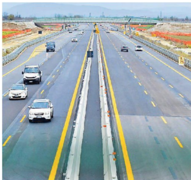
Un tratto a tre corsie lungo l'autostrada A4
