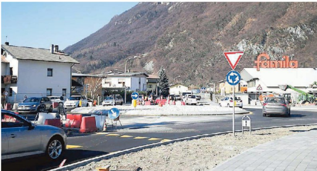
In alto lo stato di avanzamento dei lavori, sotto la nuova rotatoria di Polpet
