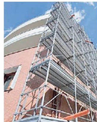
Interventi edili su una facciata
