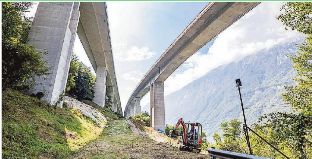
Il viadotto dell'A27 nel tratto vittoriese del Fadalto
