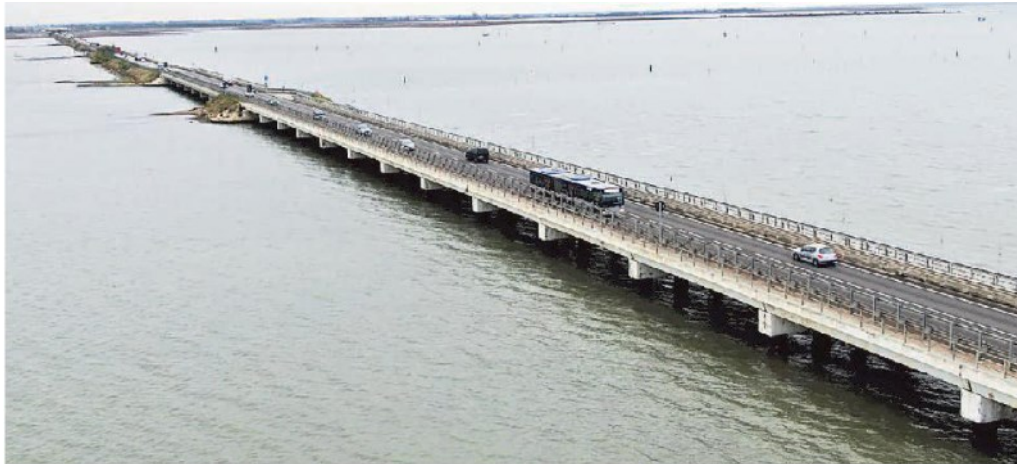
Il ponte translagunare che collega Chioggia dove sono in programma i lavori
