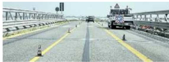
MANUTENZIONE I lavori sul ponte sono programmati per marzo
