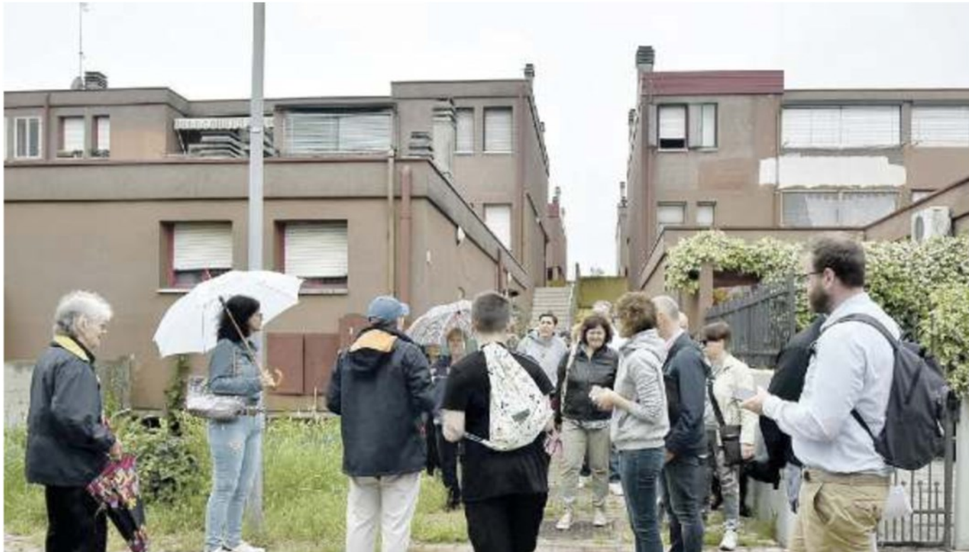
COSTRUITE NEGLI ANNI '80 Le "case marroni" del quartiere Pertini. Dalle facciate si staccano pezzi di intonaco
