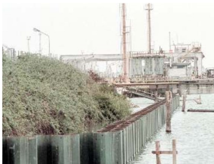
LAVORI L'area industriale di Marghera interessata alle operazioni di marginamento e, a destra, alcune palancole
