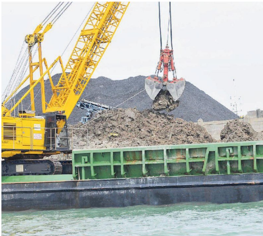
Scarico di materiali all'isola artificiale delle Tresse
