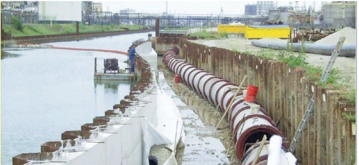
Un'immagine degli interventi di marginamento delle sponde dei canali industriali di Porto Marghera
