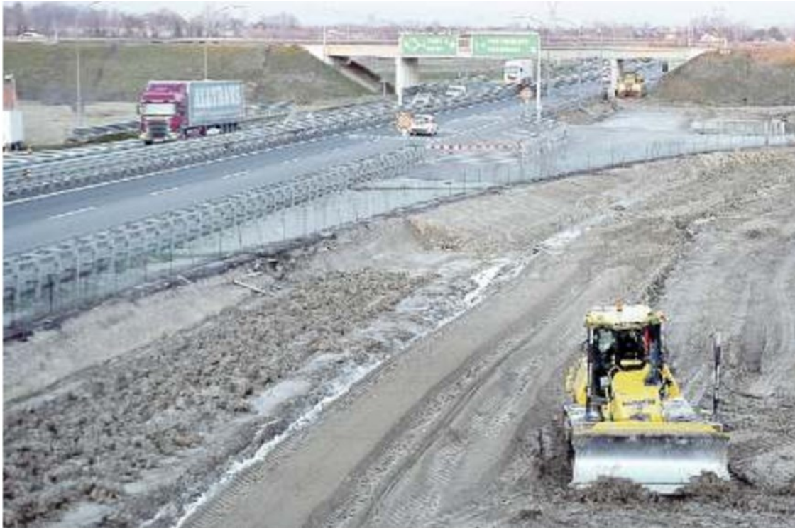
L'AUTOSTRADA SI ALLARGA Uno dei cantieri della terza corsia dell'autostrada A4
