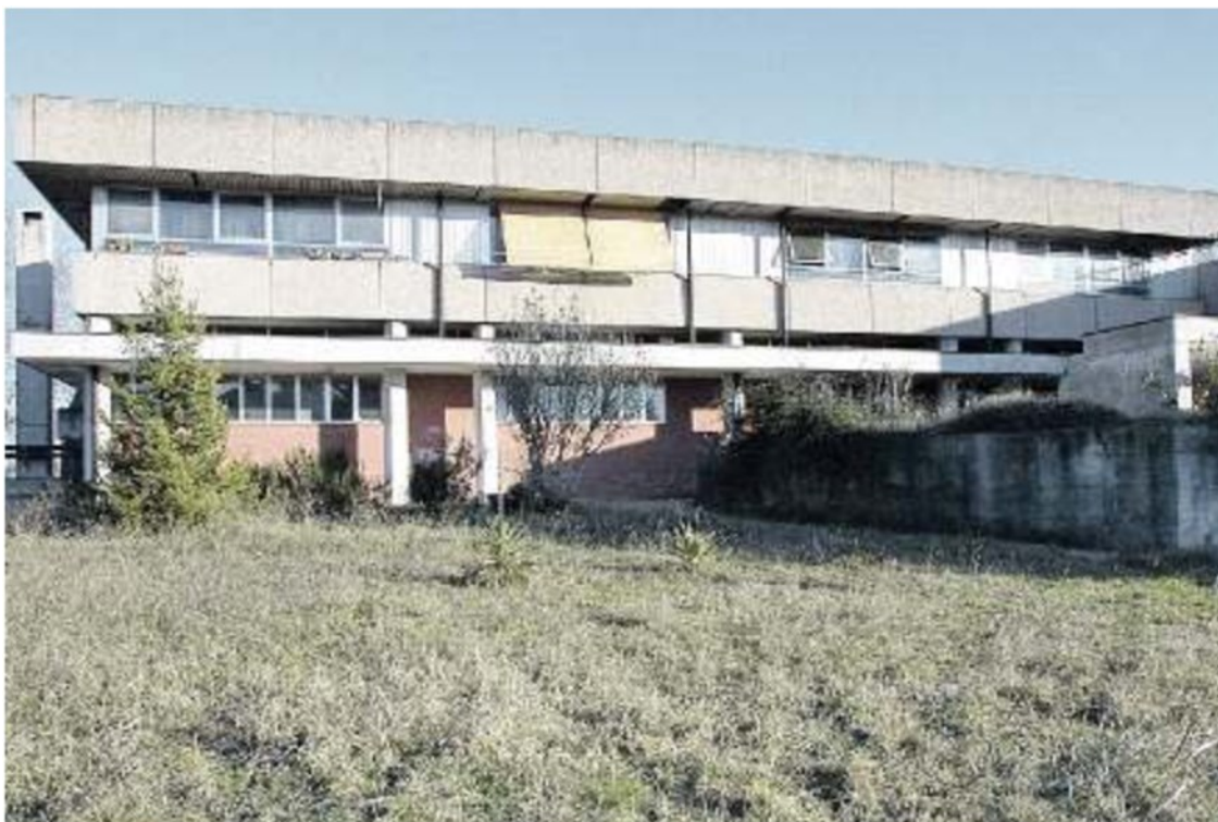
LUNGA VERTENZA L'ex scuola media Bennati prima della ristrutturazione.
