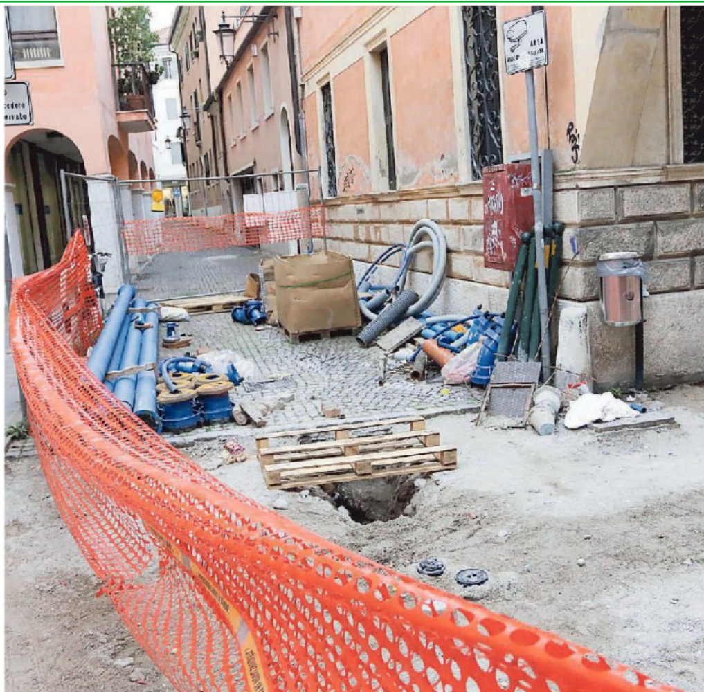
VIA MANIN e aree limitrofe sono state l'ultimo intervento sul porfido fatto in città, due anni fa
