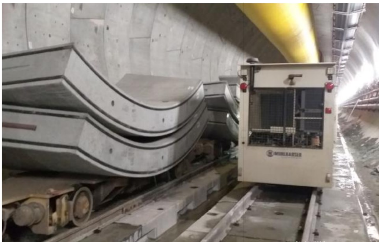
Il treno che trasporta i conci per il rivestimento delle gallerie del Brennero
