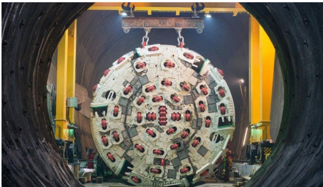
La testa fresante della TBM «Flavia» che scava la galleria di linea del lotto Mules in direzione del Brennero
