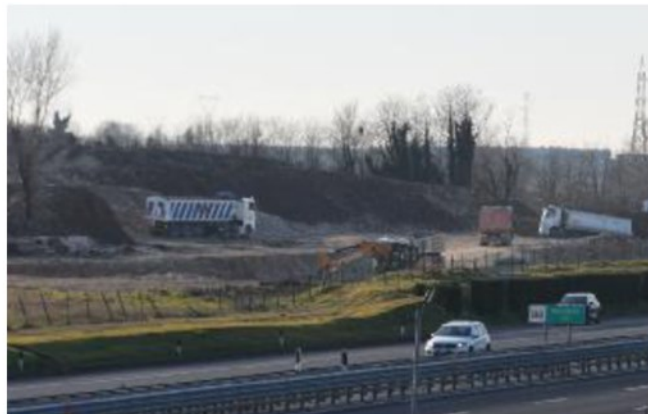
Un cantiere per la Tav all'altezza di Peschiera
