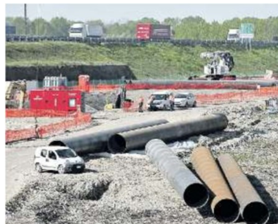
AUTOVIE VENETE I lavori per la terza corsia da Venezia a Trieste
