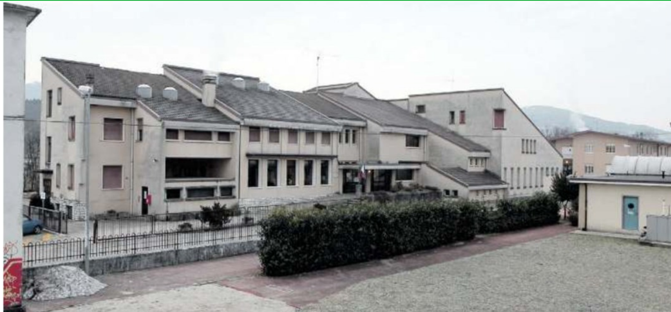
MEL Il vecchio edificio scolastico sarà raso al suolo per fare posto a quello nuovo nel quale saranno concentrate tutte le scuole del territorio di Mel
