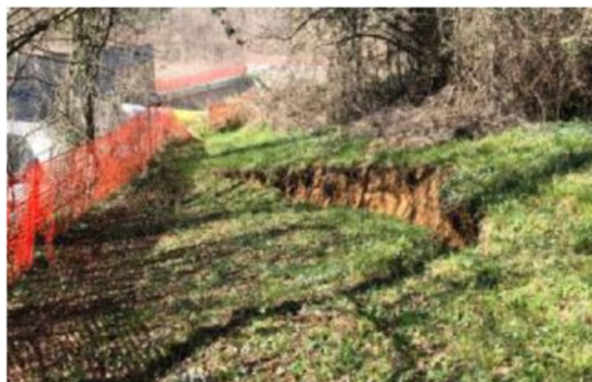
Lo smottamento del terreno vicino al cantiere della Pedemontana
