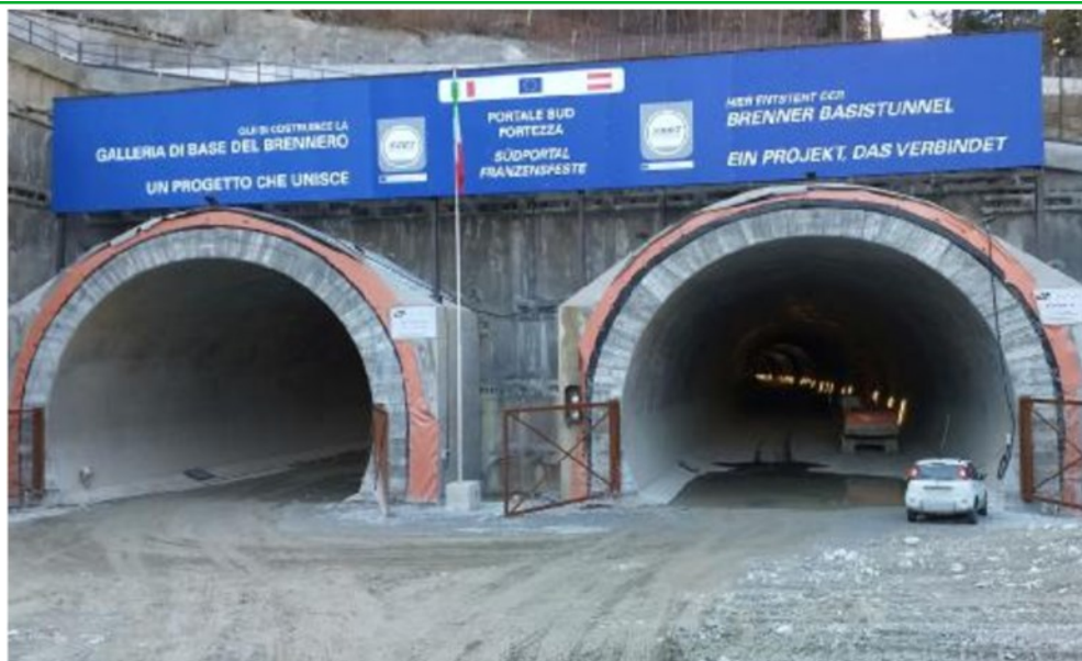
Le due gallerie di accesso già scavate per il Portale Sud a Fortezza
