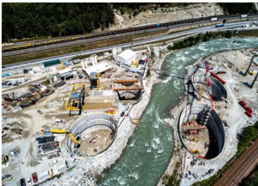
Una panoramica del cantiere per il sottoattraversamento dell'Isarco
