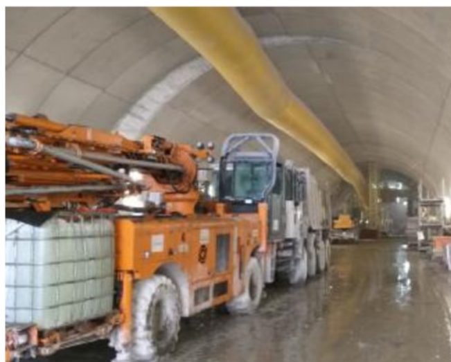
Una delle gallerie ferroviarie realizzate tra Isarco e Mules
