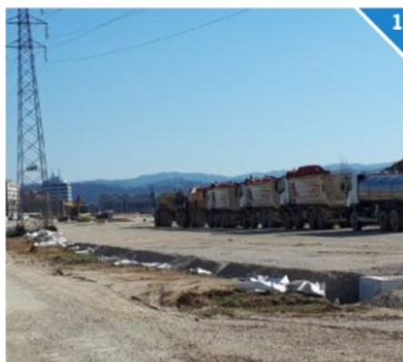
1 Camion in fila all'interno del cantiere dopo lo stop ai lavori
