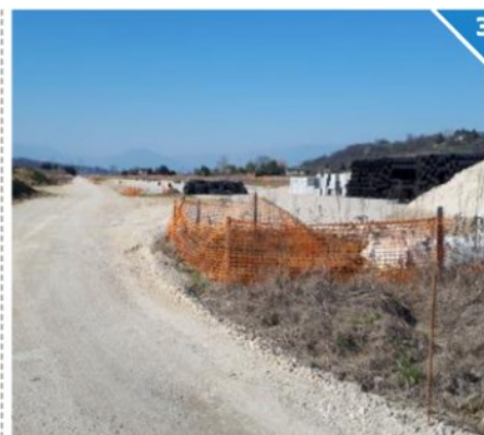
3 Un'altra immagine scattata nel cantiere deserto della tangenziale
