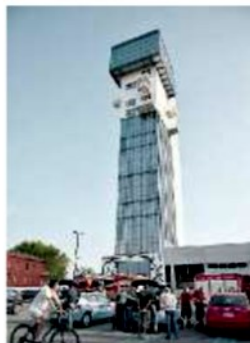
VIA TORINO Si completa l'area dell'ex deposito Actv
