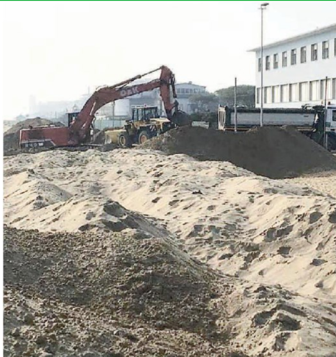
Lavori di ripascimento sulla spiaggia della Pineta
