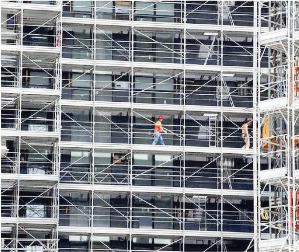
Un cantiere edile: la direttiva della Regione riguarderà quelli delle opere pubbliche
