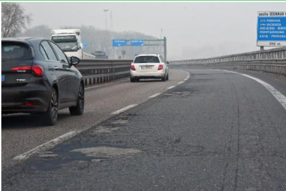
Asfalto dissestato sulla Transpolesana all'altezza dello svincolo di Legnago
