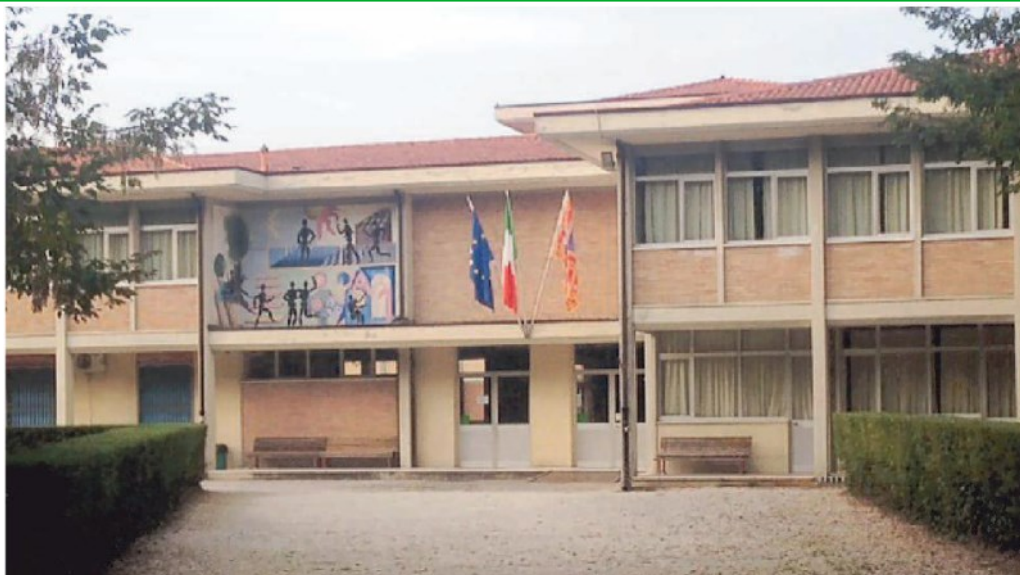
L'adeguamento sismico della scuola media di Noale è tra gli interventi previsti
