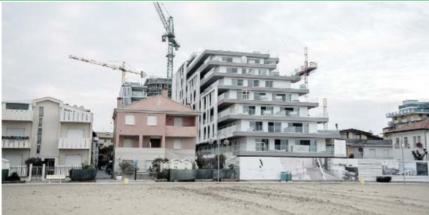
GRANDI LAVORI Cantieri e gru al lavoro nella fascia fronte mare a Jesolo
