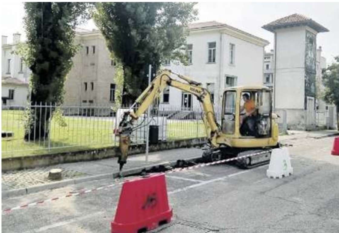
DOLLO Il Comune ha sospeso diversi cantieri. Nella fotografia in alto l'assessora Giorgia
