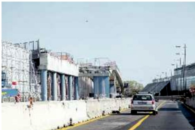
VIA LIBERTÀ La rampa di discesa del cavalcaferrovia è già stata in larga parte demolita prima dello stop ai lavori
