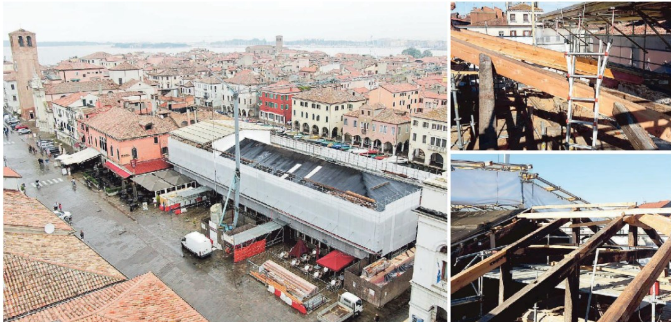
Nella foto grande una vista dall'alto dell'intervento su Palazzo Granaio. A destra le ultime foto dello stato dei lavori prima del nuovo, inatteso, stop all'intervento di recupero della struttura. Sostituite le travi con l'intervento di somma urgenza e il posizionamento di una cornice in acciaio di rinforzo per evitare il crollo. Mancano le finiture dei muri e i pavimenti: inizialmente la conclusione dei lavori era prevista entro aprile
