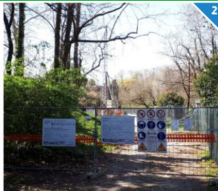
2 Si fermano anche i lavori per la riqualificazione delle serre al Querini
