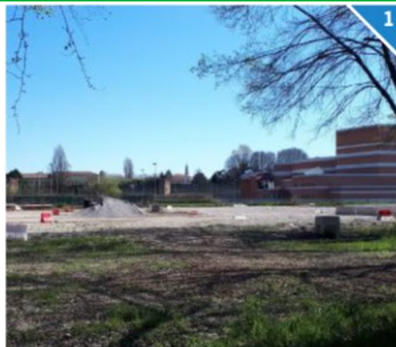
1 Stop al cantiere per la realizzazione di un parcheggio all'ex Pp6
