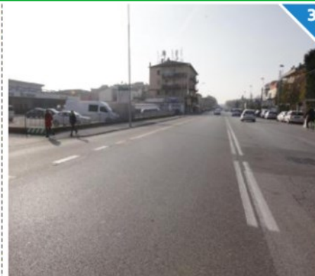
3 Sospeso l'intervento per lo spartitraffico in viale S. Lazzaro
