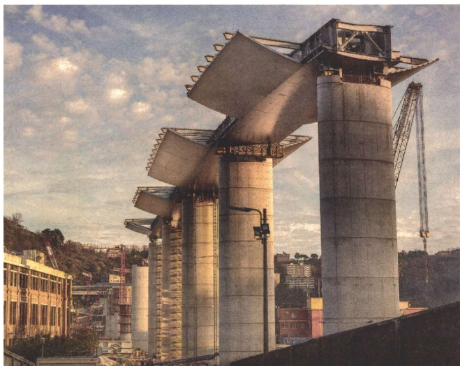
Il nuovo ponte Morandi in costruzione
