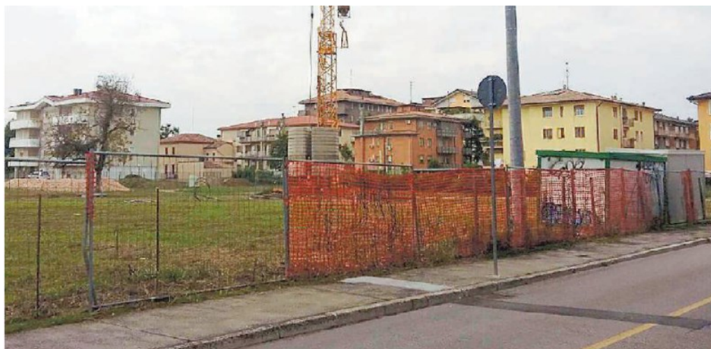
Il cantiere per la costruzione degli alloggi di edilizia popolare in via Forno a Tencarola di Selvazzano
