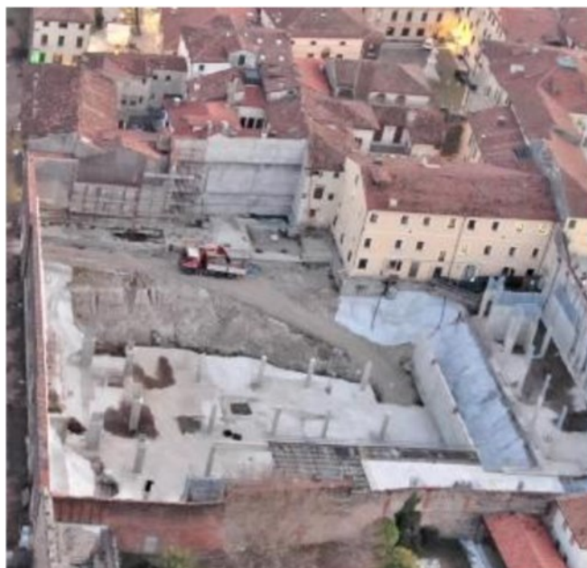
Il cantiere del Polo Santa Chiara in una veduta dall'alto CECCON
