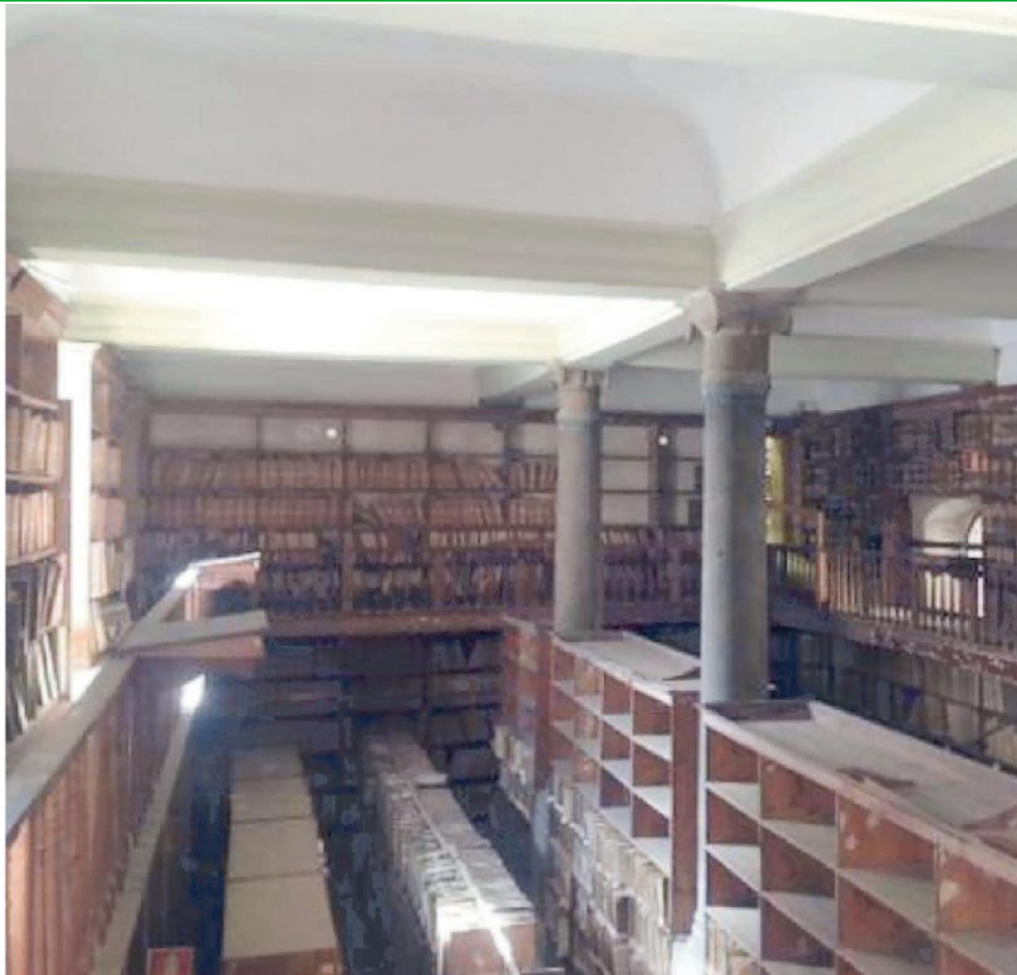
Gli spazi interni dell'Archivio di Stato saranno interessati da lavori di restauro
