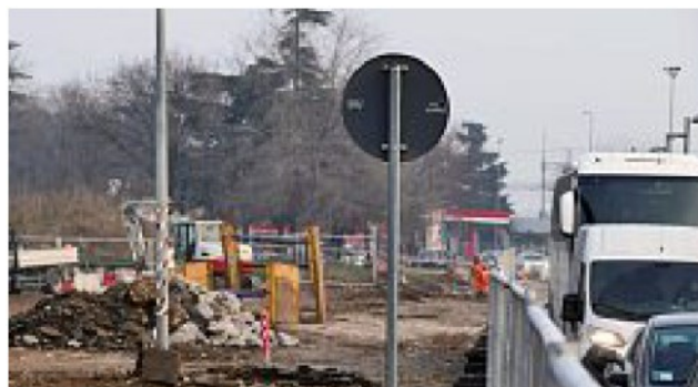
I lavori In via Città di Nimes a giugno partirà il cantiere per il sottopasso
