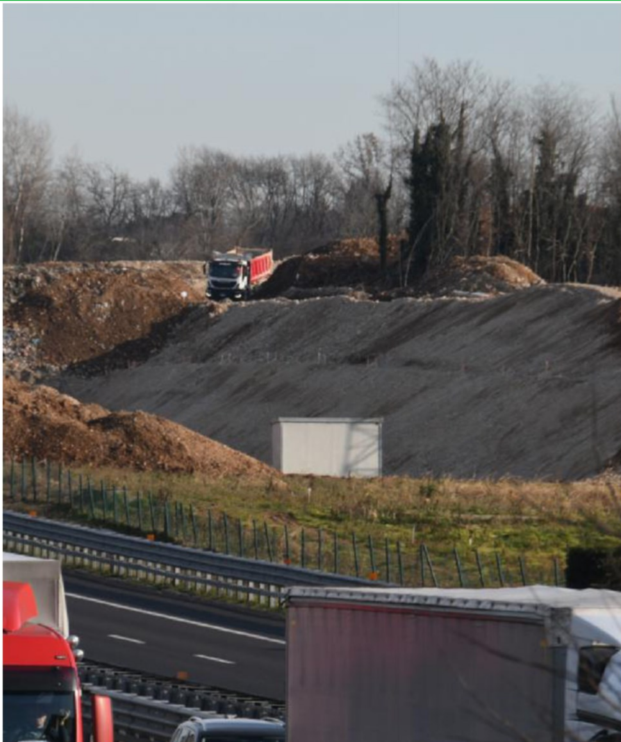
Cantiere Tav lungo l'autostrada A4 a Peschiera per la tratta Brescia-Verona
