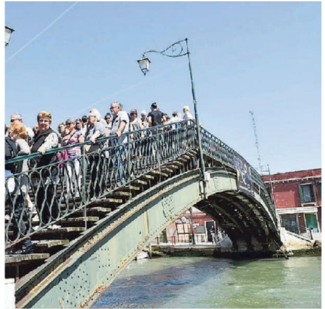
Il Ponte Longo a Murano sarà interessato da lavori di rifacimento
