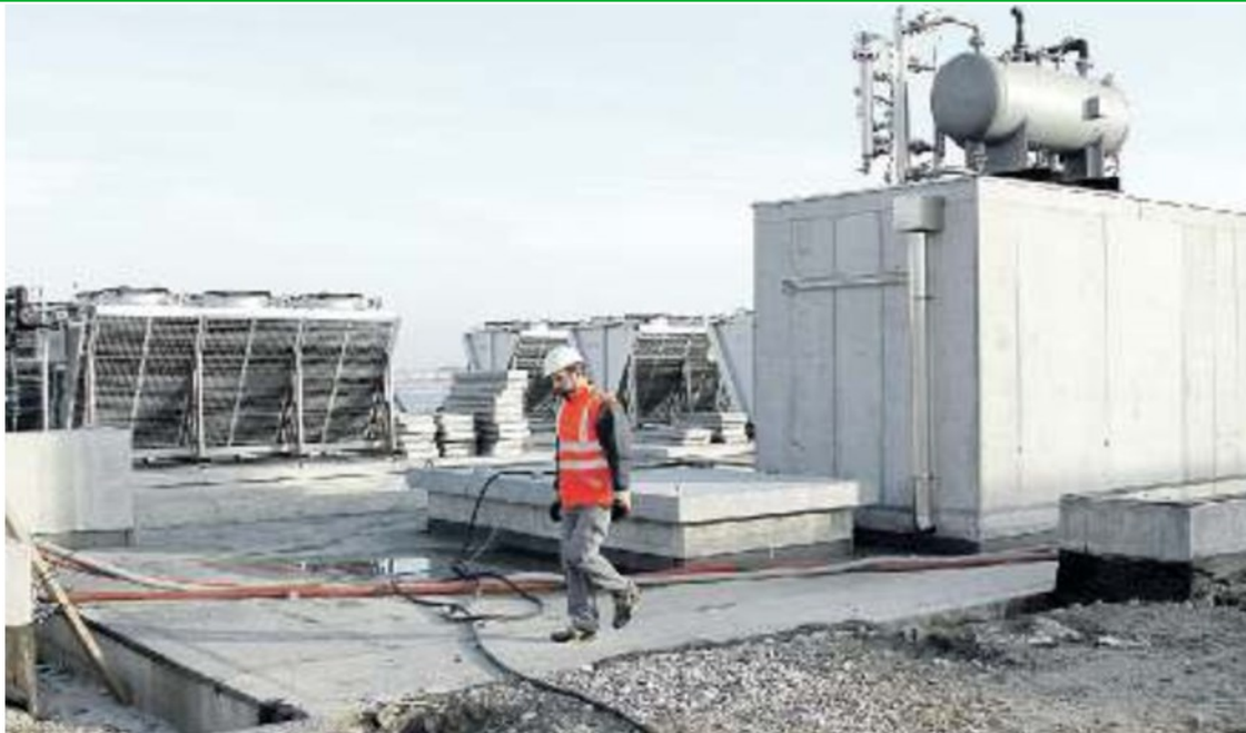
IL NODO DEI LAVORI Un'immagine dei cantieri del Mose: le imprese chiedono che si torni a fare ricavi
