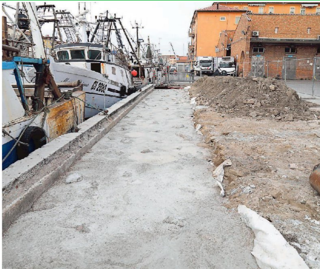
I lavori alla banchina del mercato ittico di Chioggia. Per ora i cantieri sono fermi
