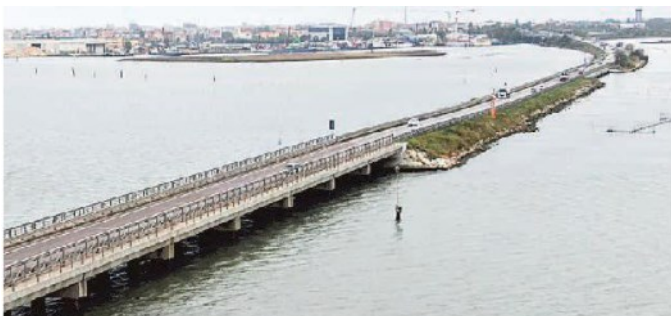
Il ponte translagunare di Chioggia al centro degli interventi
