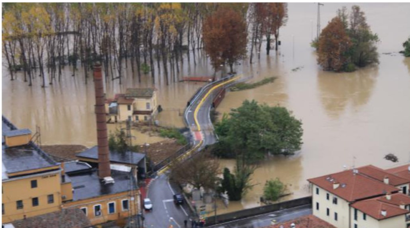
Una panoramica di Debba ai tempi dell'alluvione del 2010. Il nuovo ponte sarà realizzato tenendo conto della natura dell'area. ARCHIVIO
