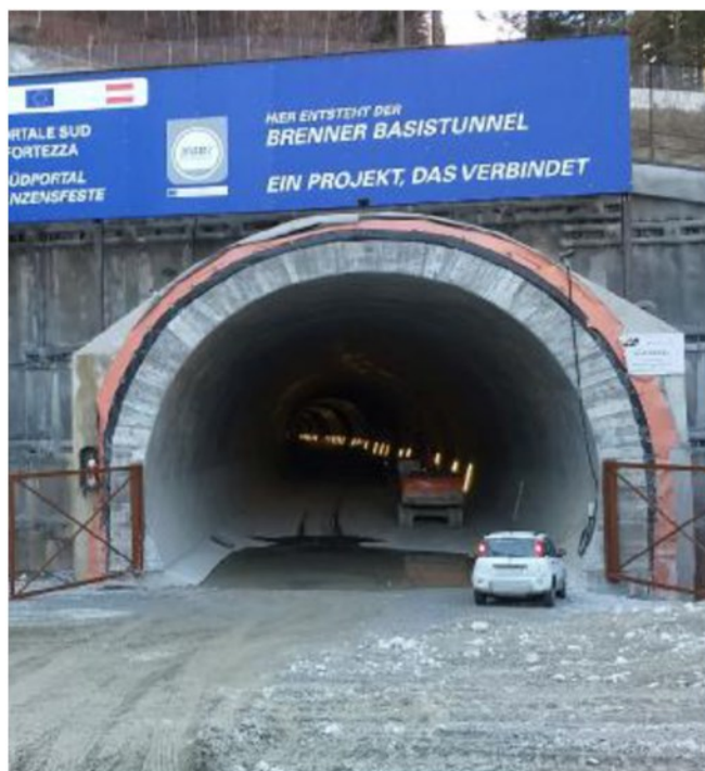
Fortezza, una delle gallerie di accesso al tunnel di base del Brennero
