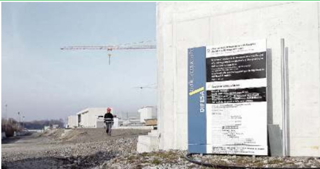
CONTENZIOSI CONTINUI Uno dei cantieri del Mose: nuova querelle giudiziaria per il Consorzio
