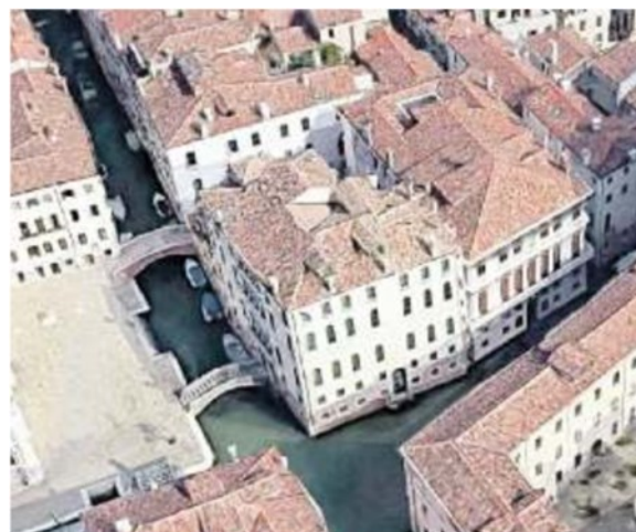
SCUOLA SUPERIORE Una vista dall'alto della sede del Tommaseo
