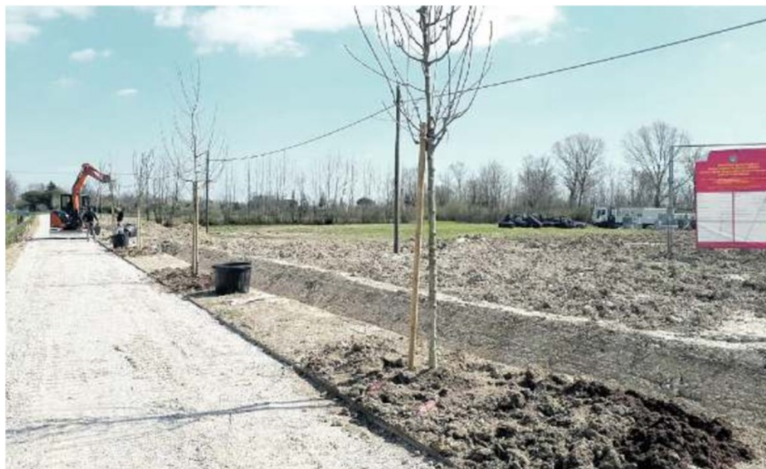
MESTRE I lavori in corso per il completamento della pista ciclopedonale lungo via Scaramuzza vicino al Forte Mezzacapo
