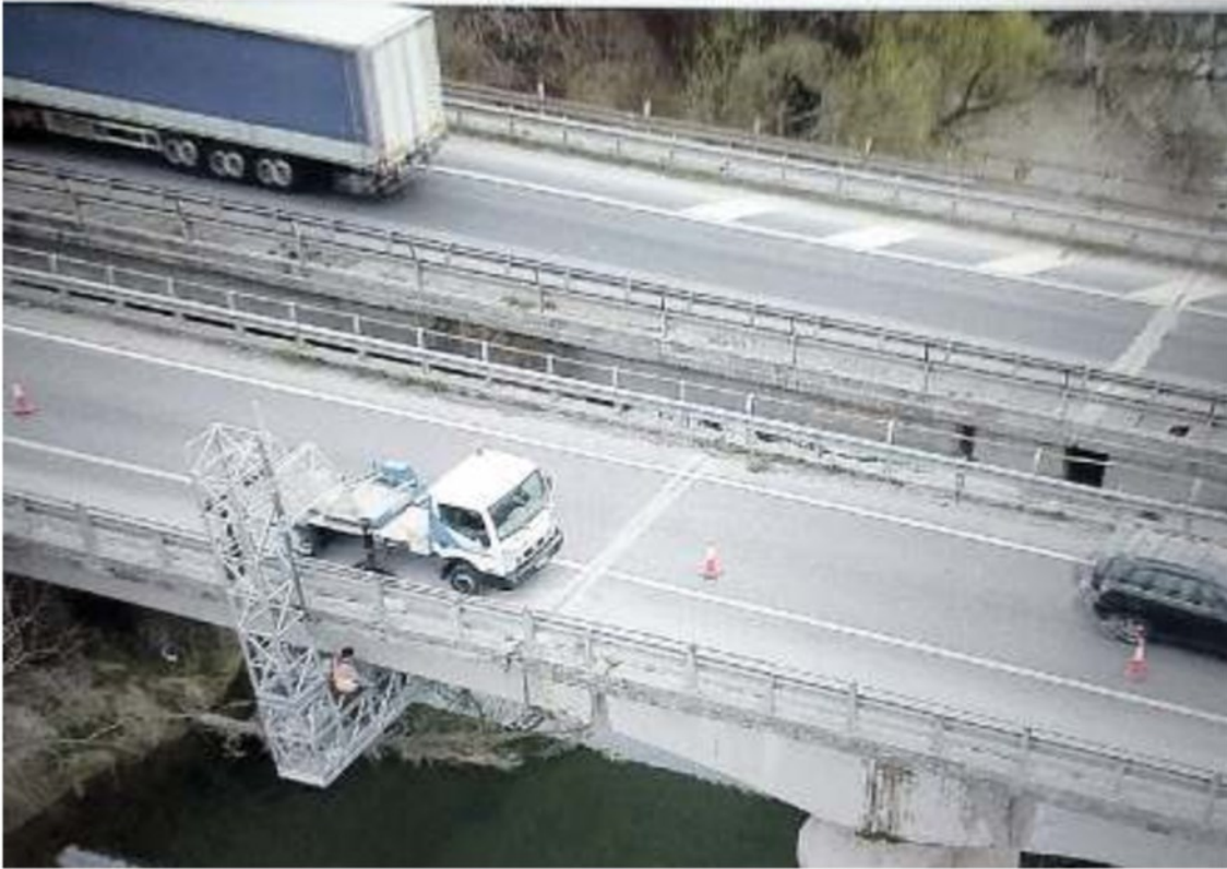
CONTROLLI Il ponte ripreso dal drone: questo il tratto destinato alla doppia corsia, l'altro a ciclopista
