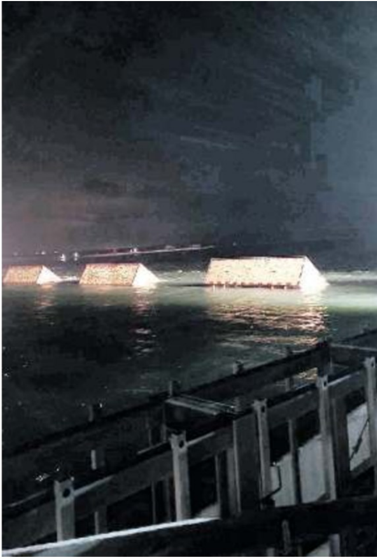
L'OPERA IN NOTTURNA Uno dei test di sollevamento del Mose
