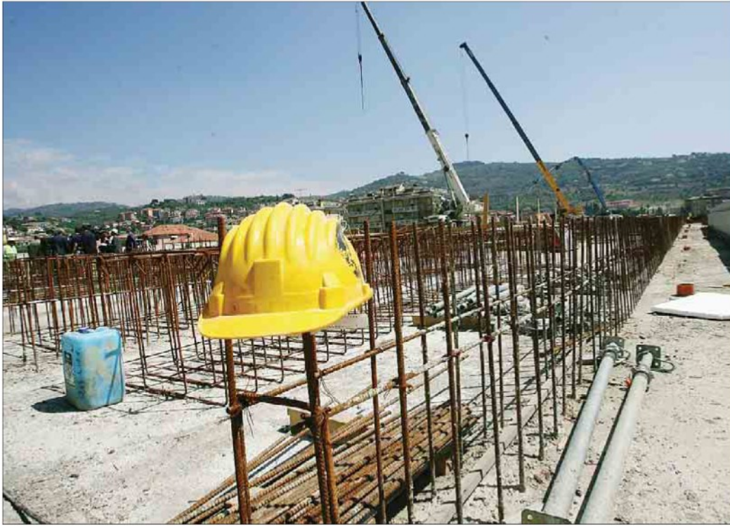
I cantieri edili vogliono ripartire ma sono molte le misure necessarie per lavorare in sicurezza
