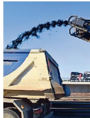
I lavori ripresi in autostrada
