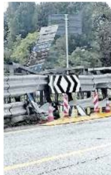
IL CANTIERE Il ponte sul Taglio era in stato precario
