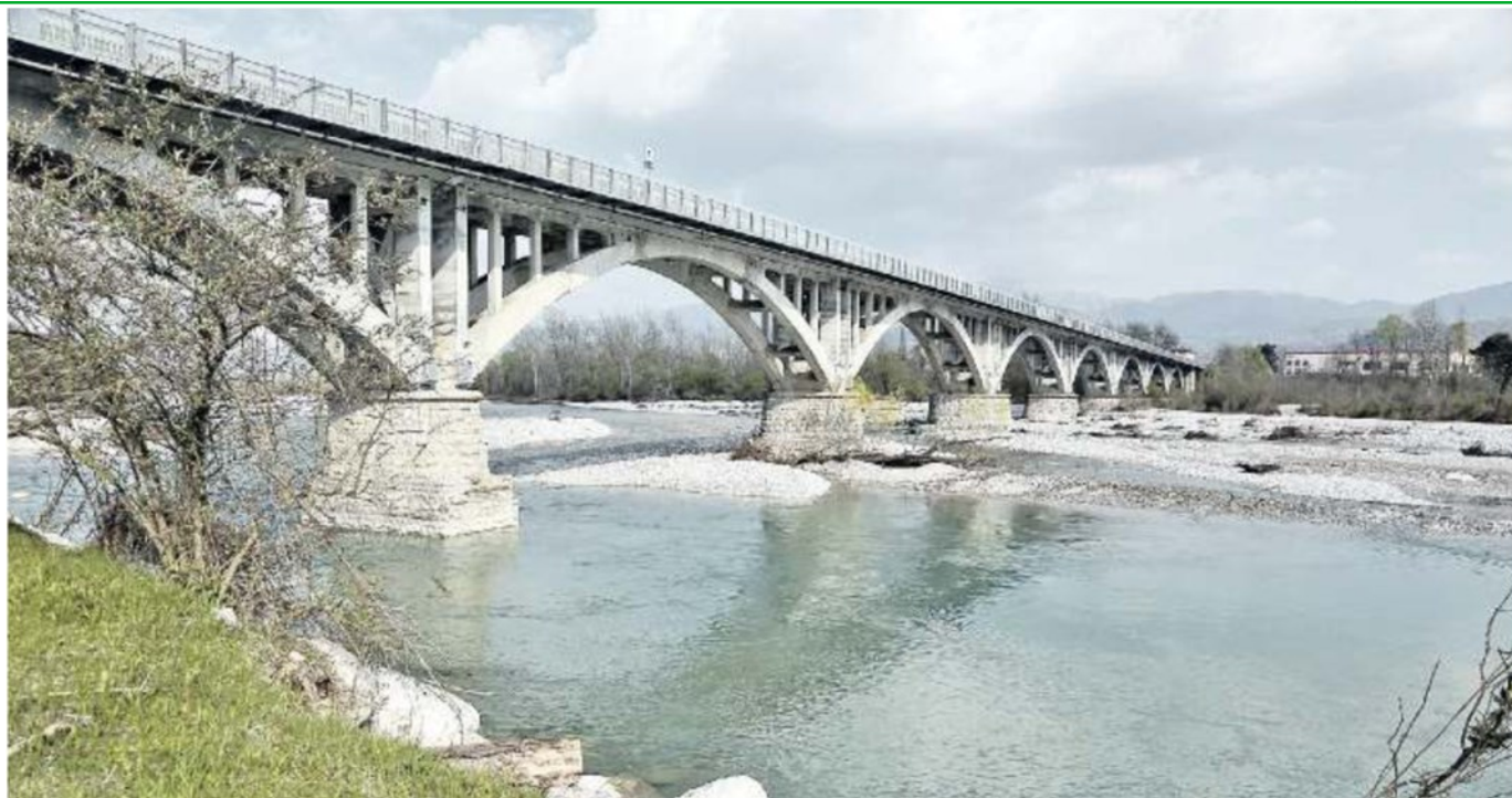
TRICHIANA Il ponte San Felice già 13 anni fa era stato oggetto di una maxi-ristrutturazione da 16 milioni di euro. Ora si ipotizzano lavori mal eseguiti
