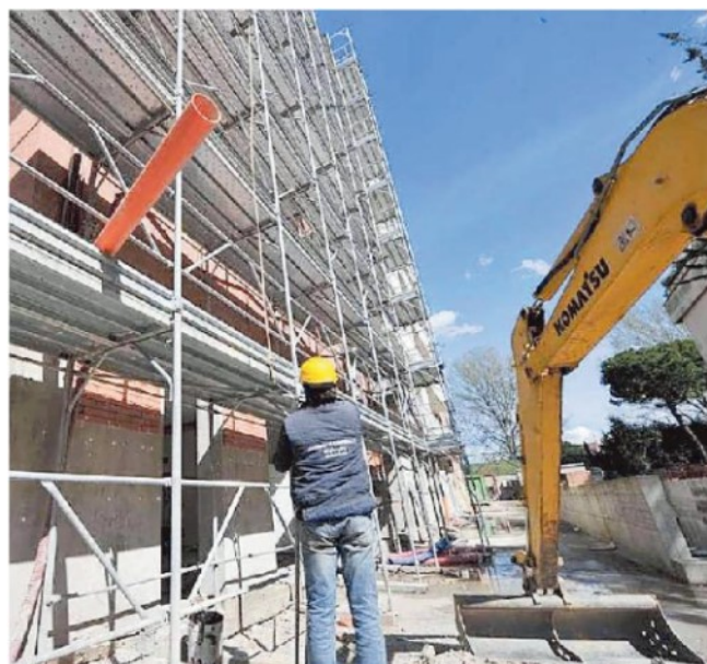
Un operaio edile al lavoro in un cantiere
