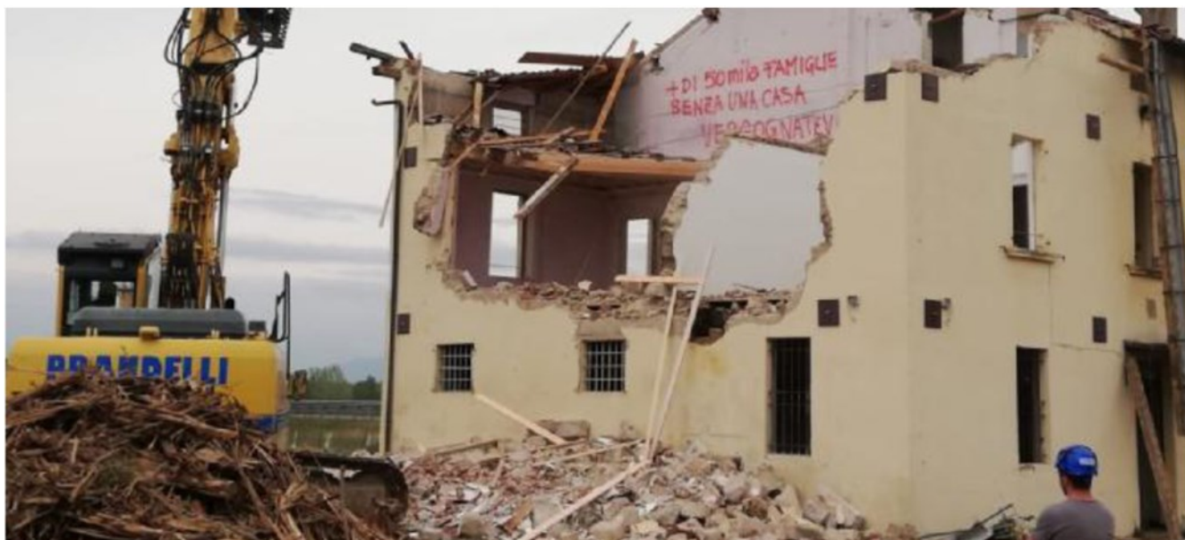
L'abbattimento dello stabile a Desenzano per far posto all'alta velocità
