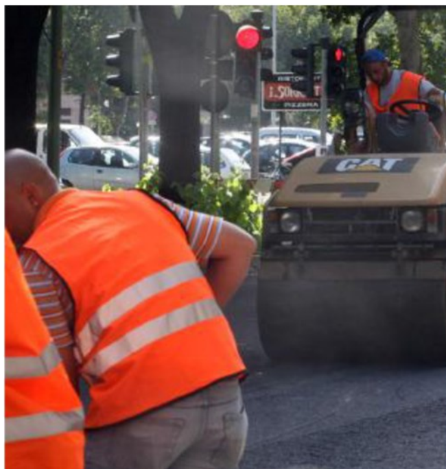
Un cantiere per asfaltare una strada e metterla in sicurezza
