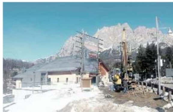
INTERVENTI Le trivelle in azione al ponte Corona sulla sponda sinistra del torrente Boite: qui sorgerà la variante Anas
