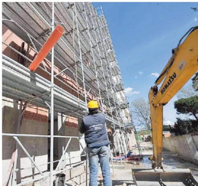
Operaio al lavoro in un cantiere edile
