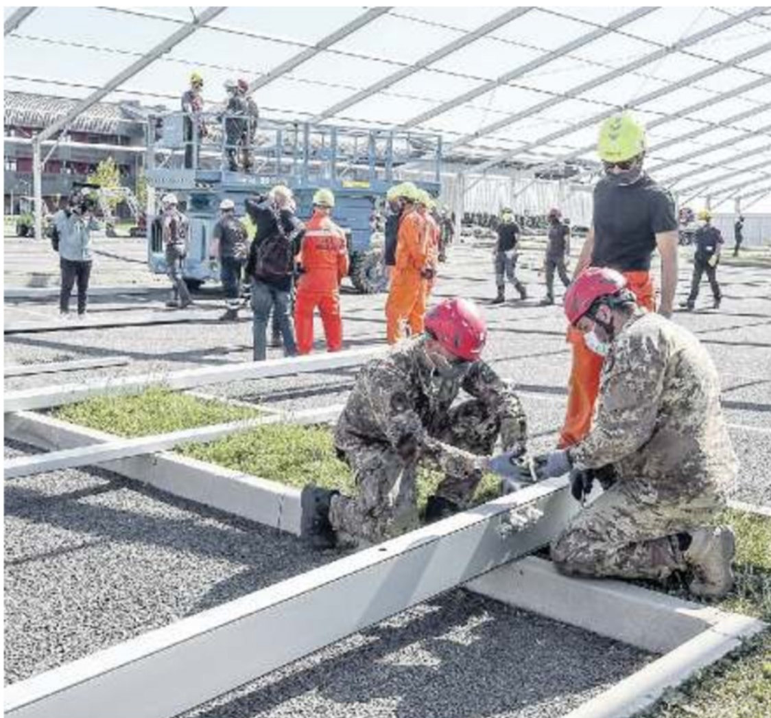
IL CANTIERE Ottanta volontari sono impegnati nel montaggio della struttura
