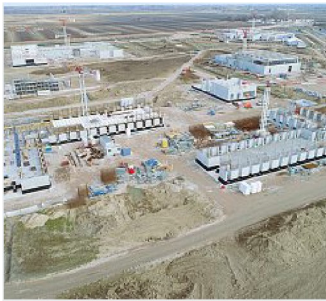
Avanzamento lavori IL cantiere per realizzare l'H-Campus a Ca' Tron
