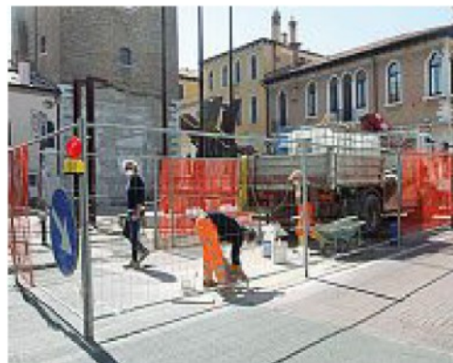
All'opera I lavori in via San Pio X (Foto Errebi)
