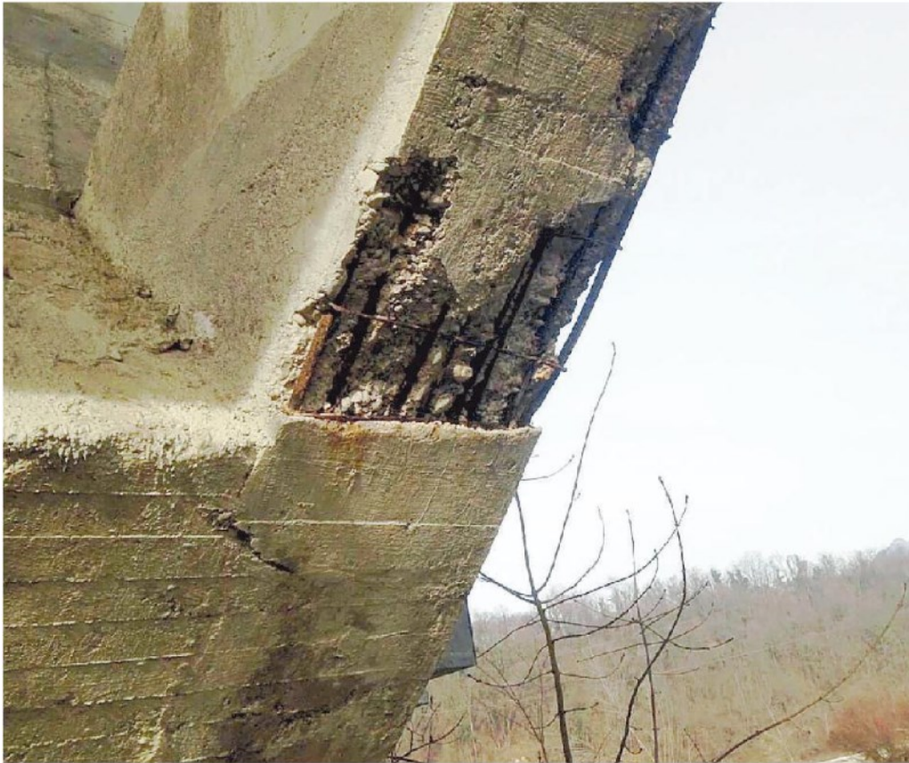
Un punto del ponte di San Felice con l'armatura metallica venuta alla luce
