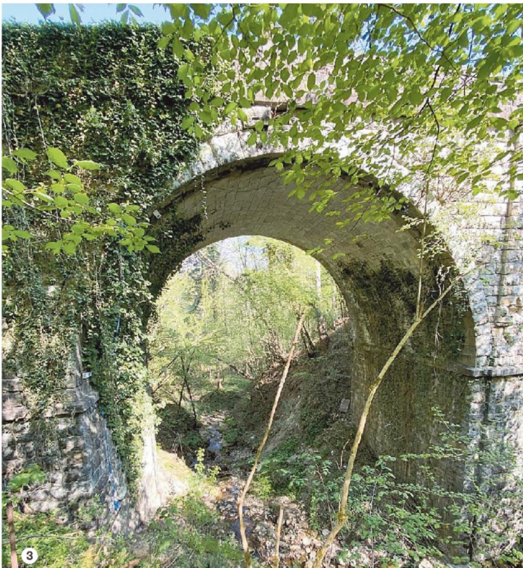
Nelle foto 1 e 2 la fessura che si può vedere sotto la volta del ponte, il primo dopo la frazione di Antole viaggiando in direzione Casani. Nella foto 3 l'infrastruttura vista dalla strada romana sottostante
