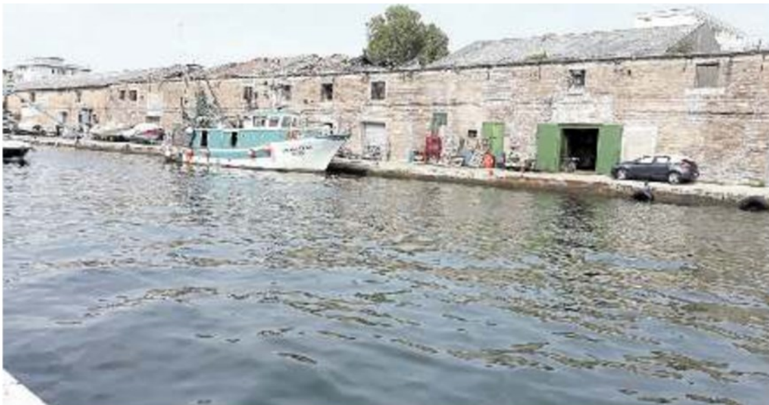
CHIOGGIA Nella foto le strutture dell'area portuale che dovranno essere bonificate perché realizzate in eternit. In alto a destra Strada Madonna Marina
