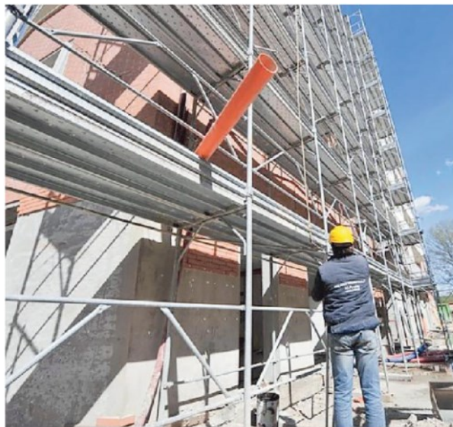
Al lavoro in un cantiere edile ARCHIVIO
