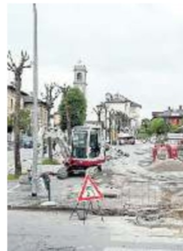
CASTION Lavori su marciapiedi e piazza per 43mila euro
