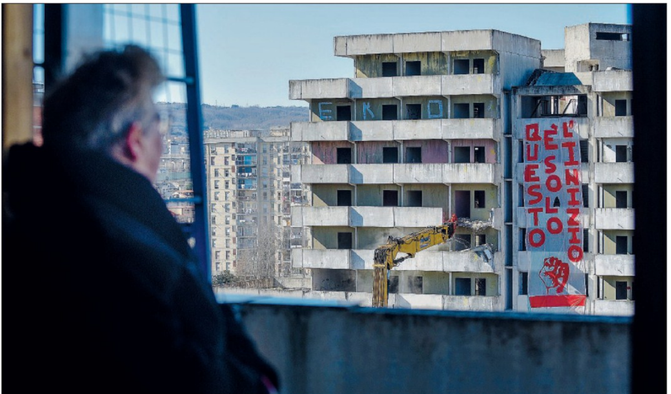
La demolizione di una delle Vele di Franz Di Salvo, il 20 febbraio scorso a Scampia (foto LaPresse)
