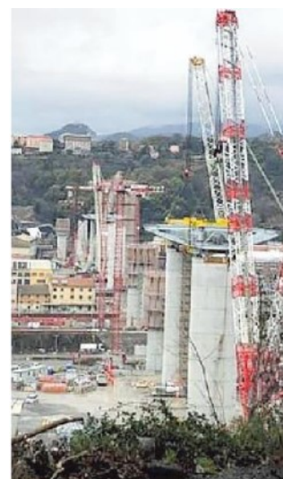
Il cantiere di Ponte Morandi
