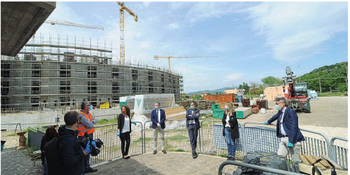
Si ricomincia Sopralluogo con i sindaci del territorio, la direzione dell'Usl 8 e i responsabili dell'impresa che sta eseguendo i lavori (Parisotto)
