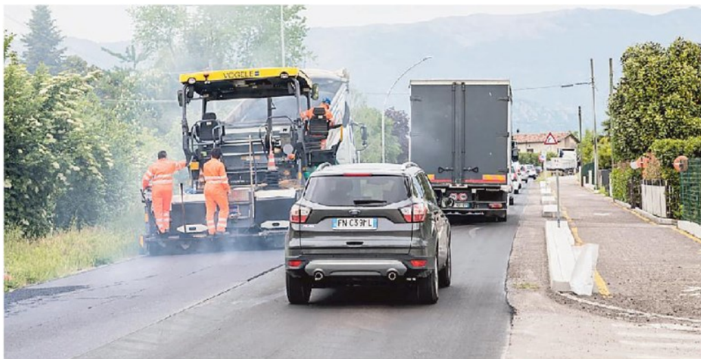
I lavori di asfaltatura in corso lungo il Menarè
