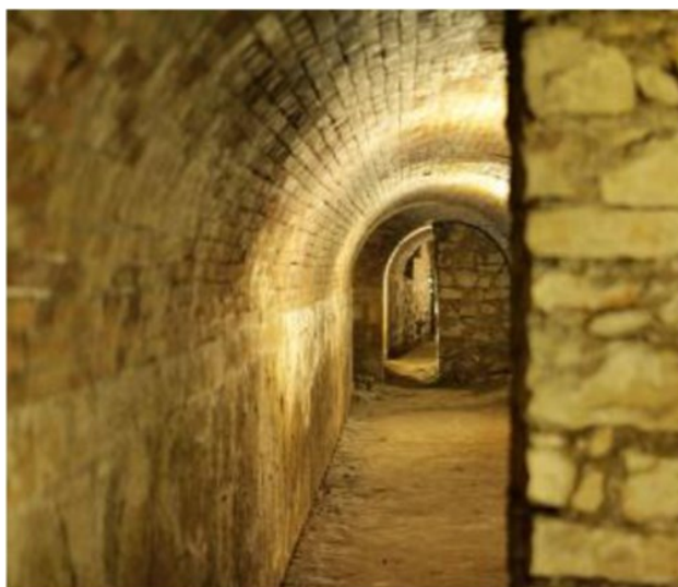
Le gallerie sotterranee del bastione di San Giorgio
