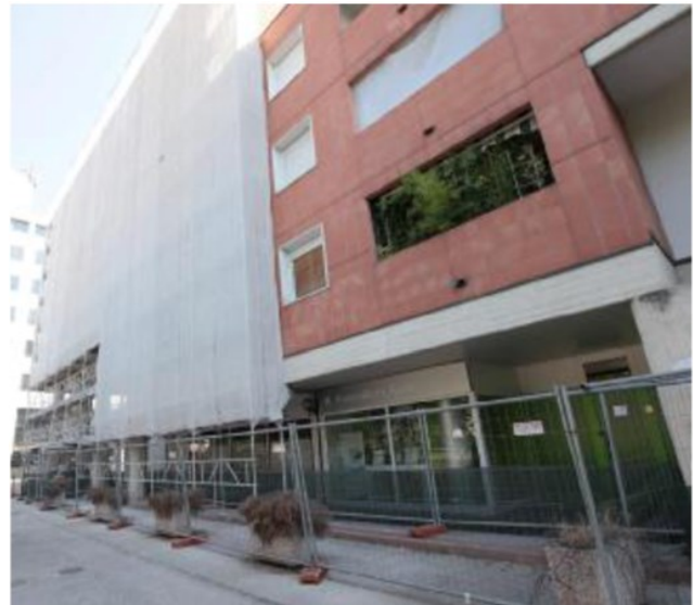
La facciata di una palazzina in ristrutturazione FOTO ARCHIVIO
