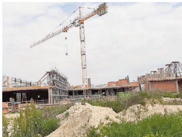
Il cantiere natatorio di viale Della Repubblica
