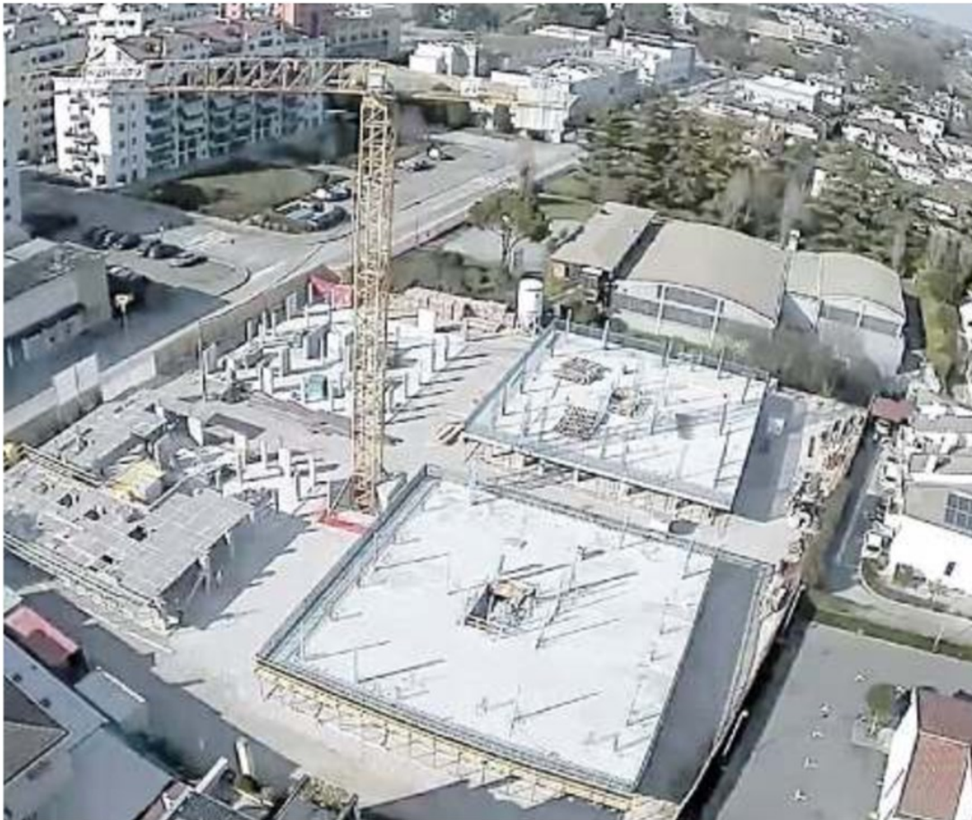
SETTORE EDILE Una veduta aerea dei cantieri Mengato, uno dei gruppi più noti della provincia
