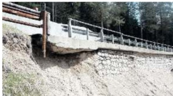
STATALE 51 Il tratto di Alemagna minacciato da un vasto fronte di frana, ma il transito non è stato interdetto nemmeno ai tir
